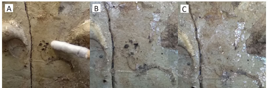
Fig. 49 A-B-C: Limpieza de la suciedad antes y después.
