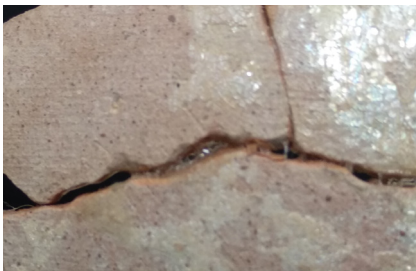
Fig. 34: Desgaste en las uniones.
