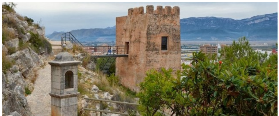
Figura 6. Torre de La Reina Mora
