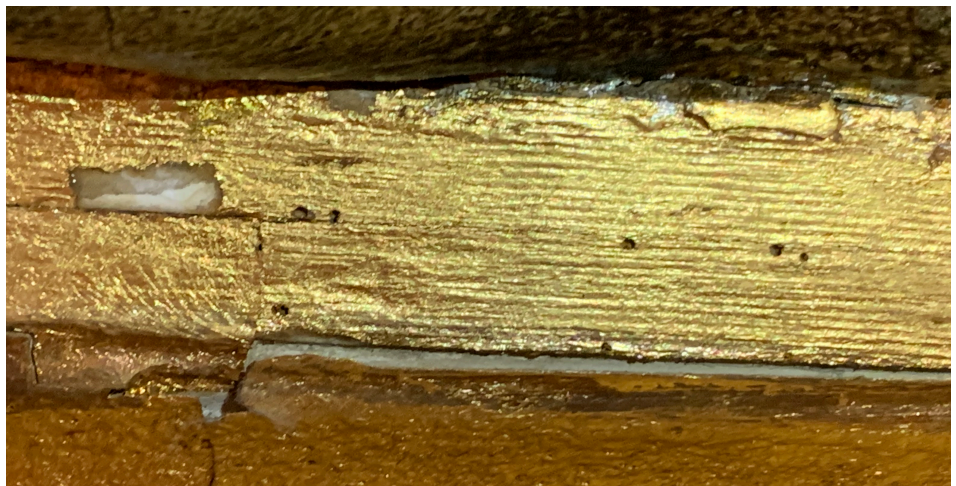
Figura 41. Orificios producidos por insectos xilófagos
