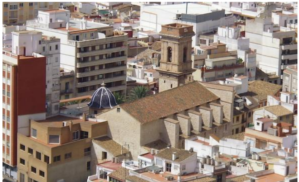
Figura 14. Vista aérea de la Iglesia
