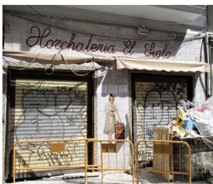
Fig. 30. Horchatería El Siglo cerrado por obras.
