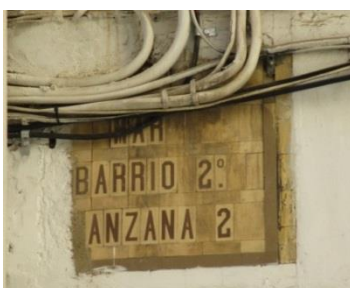
Fig. 10. Panel de teselas, cuyas palabras "Distrito del Mar" están tapadas por el cableado eléctrico.
