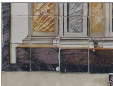
Fig. 135. Falta de alineación de azulejos.
