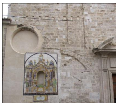
Fig. 118. Vista actual de la fachada en donde se ubica el retablo.
