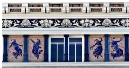
Fig. 7. Detalle de fachada del edificio Monforte. Paneles de bacantes, con sus azulejos colocados diagonalmente.
