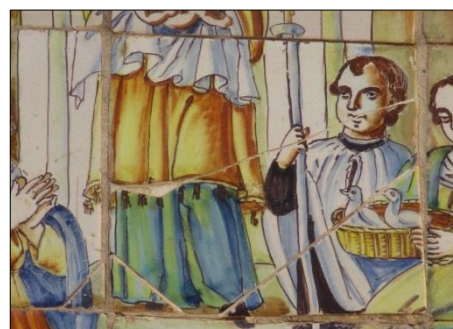
Fig. 92. Rotura y pérdida de lienzo cerámico.
