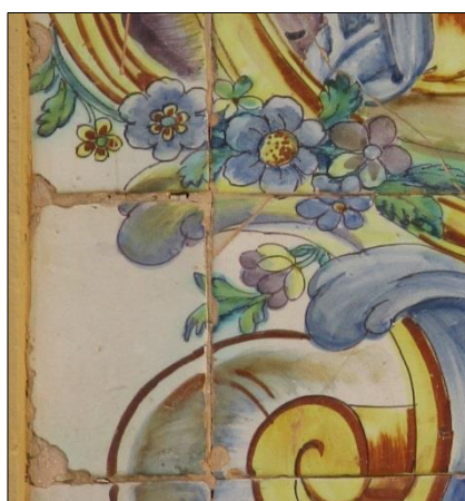
Fig. 96. Descantillados de bordes.
