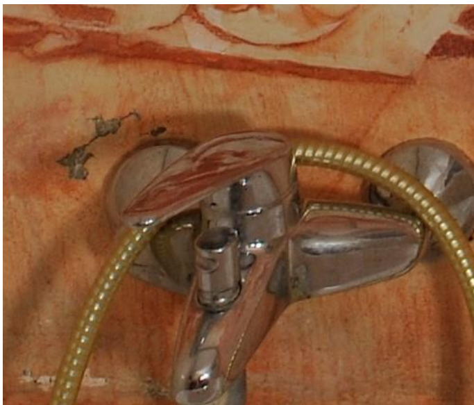
Figura 38. Detalle de la zona alrededor del grifo.
