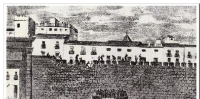
Figura 17. Grabado del inicio del derribo de la muralla medieval de la ciudad de Valencia
