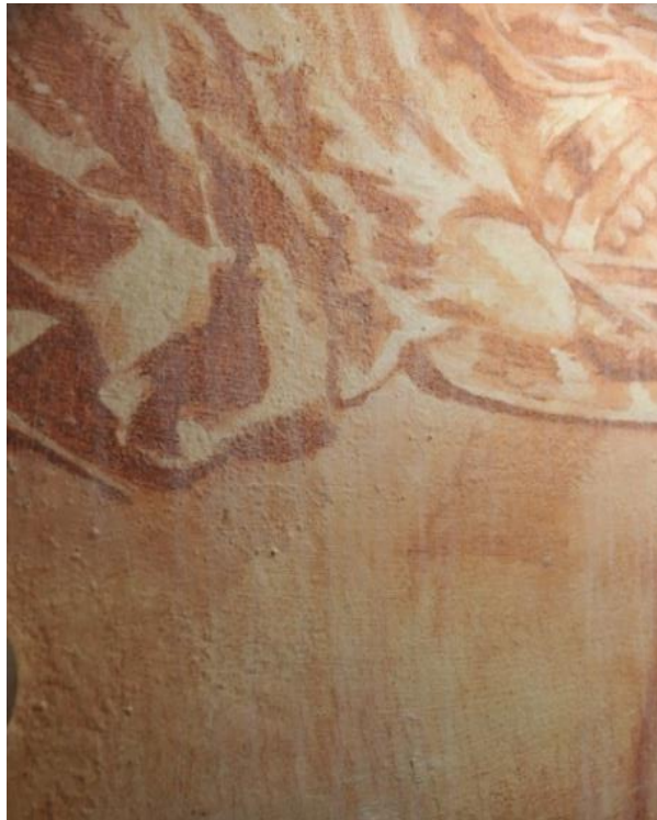
Figura 43. Detalle donde se visualizan los escurrimientos de agua en forma de velos blanquecinos.
