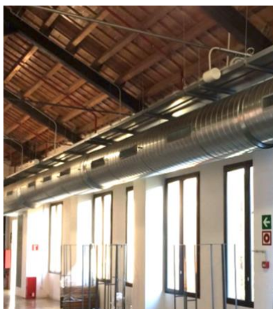
Figura 50: Ejemplo de un sistema de climatización.
