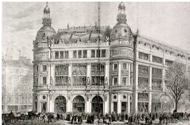
Fig.6. El nuevo edificio de Printemps (arq.: Paul Sédille). Reconstrucción después del incendio. Monumentalización de la primera arquitectura del consumo emulando las formas de los otros grandes edificios de la ciudad burguesa.
