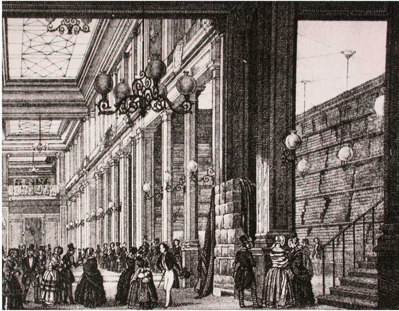
Fig.3. Interior de los almacenes A la Chaussée d'Antin de París en 1844. El espacio de lo social toma la delantera. Las estanterías monstruosas aparecen al fondo, como ocultas por el mismo edificio.
