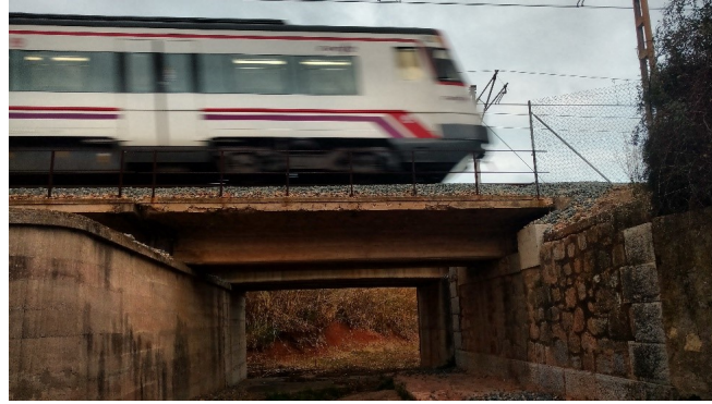
Figura 3.1: Puente de hormigón armado construido a principios de los años 70 (antigüedad aproximada 60 años).
