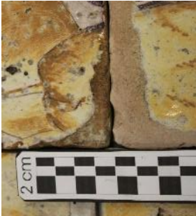
Fig. 16 Erosión bordes
