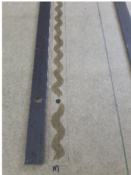
Fig. 33 Colocación de las pletinas sobre el tablero
