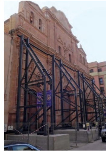
Imágenes interior y exterior del templo con medidas de sujeción durante las intervenciones. (De la Hoz, 2012)
