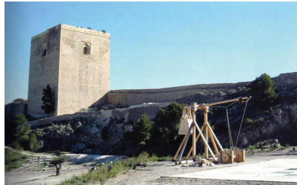
Imagen desde el interior del conjunto del castillo. (Ayuntamiento de Lorca, 2005)
