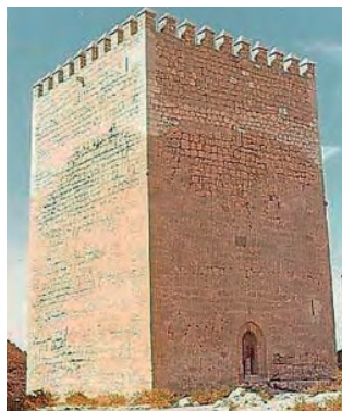
Torre del espolón tras la intervención de 1973. (San Martín)
