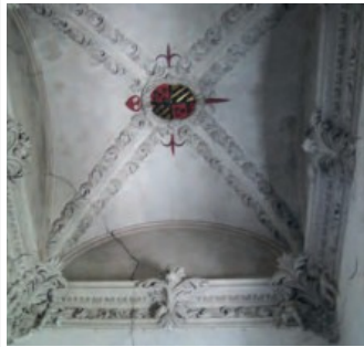
Grietas interiores en la bóveda de la escalera y en los muros del palacete. (Fernández Guirao, 2012)
