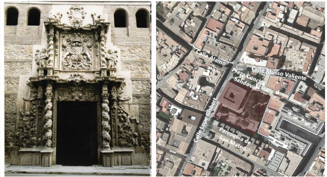
Fotografía de la fachada principal. Ayuntamiento de Lorca, 1992.. Plano de emplazamiento. Fuente: Google Maps, modificado por la autora.
