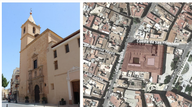
Fotografía de la fachada principal. Elaboración propia. Plano de emplazamiento. Fuente: Google Maps, modificado por la autora.
