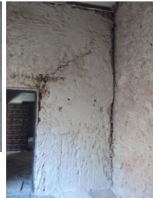
Grietas interiores en la bóveda de la escalera y en los muros del palacete. (Fernández Guirao, 2012)
