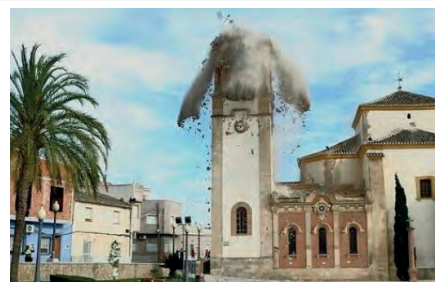
Instante en el que colapsa la parte superior de la torre durante el segundo temblor. (Anónimo, 2011)
