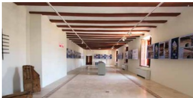
Imagen del nuevo museo con forjado restaurado de viguetas de madera y revoltones de yeso.
