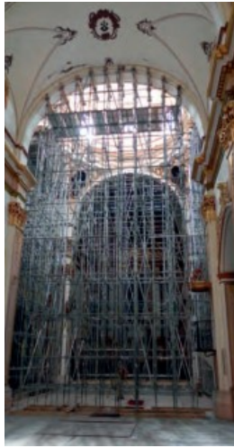
Imágenes interior y exterior del templo con medidas de sujeción durante las intervenciones. (De la Hoz, 2012)
