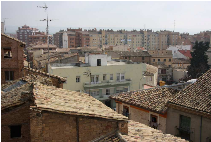
Fig.1. J. L. de León, Casa Polo, 1932, vista de la inserción en la ciudad consolidada.
