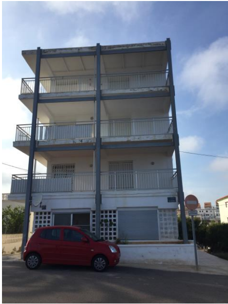
Imagen 2. Fachada de edificio de Oropesa del Mar. Fuente: Propia.
