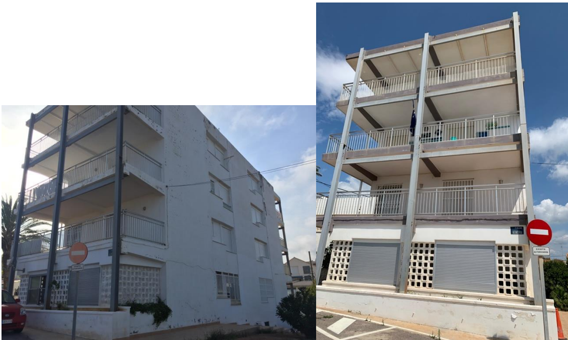
Imagen 23. Edificio con mantenimiento. Imprimación de frentes de forjado. Fuente: Propia.
