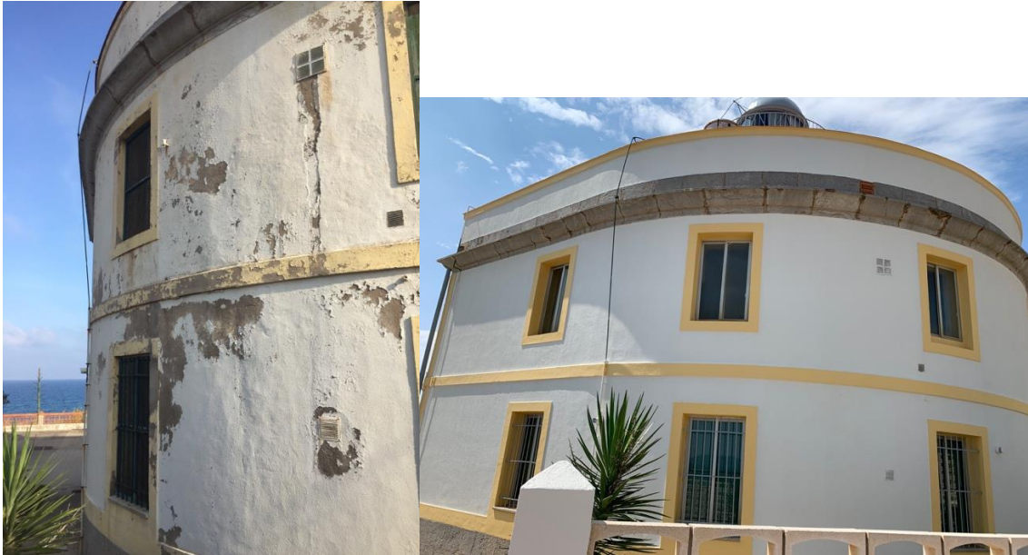
Imagen 22. Edificio con mantenimiento. Pintura y acabados de fachada. Fuente: Propia.
