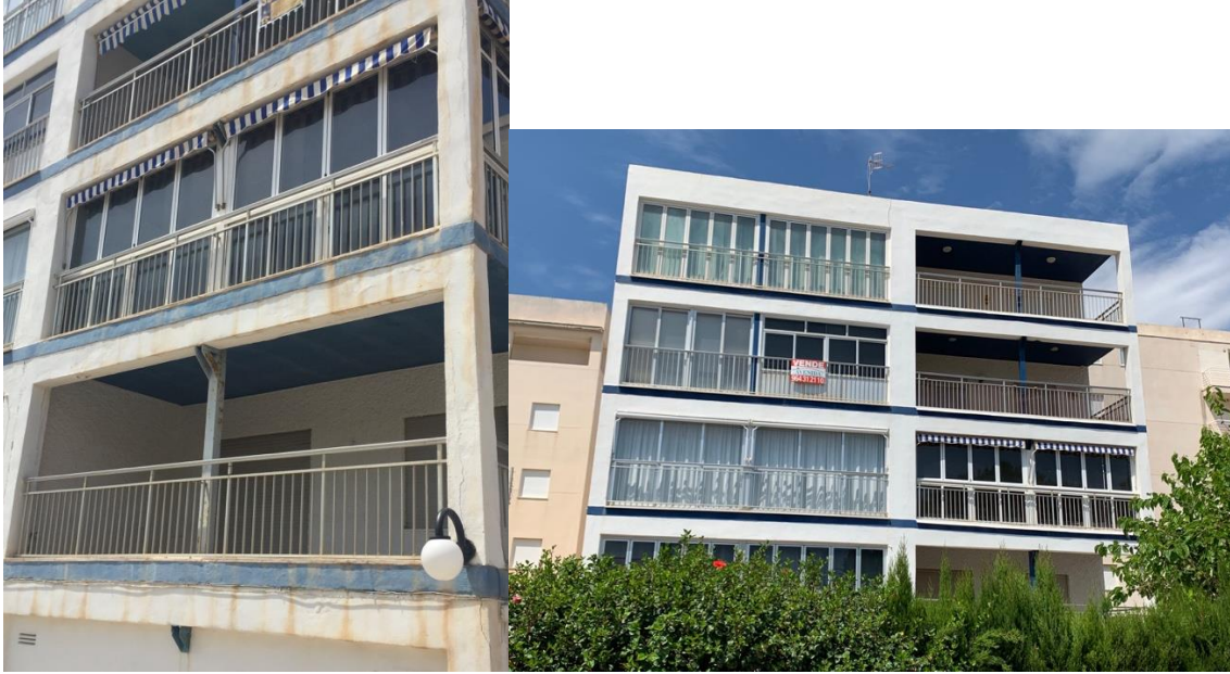
Imagen 24. Edificio con mantenimiento. Imprimación de frentes de forjado. Fuente: Propia.
