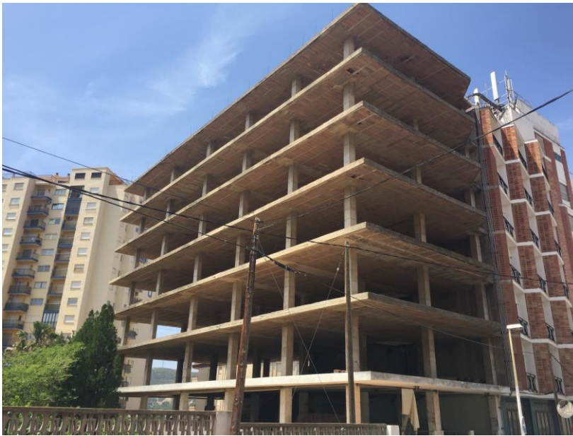
Imagen 14. Edificio en construcción. Fuente: Propia
