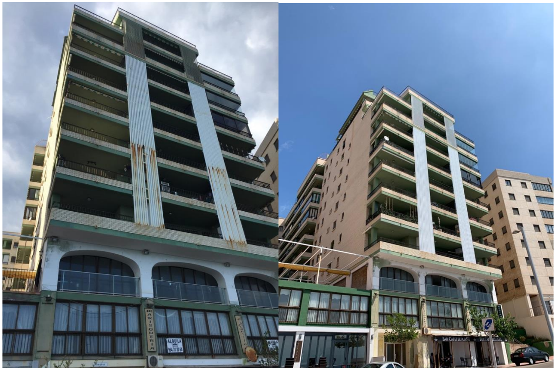
Imagen 21. Edificio con mantenimiento. Sustitución de embellecedor metálico. Fuente: Propia.
