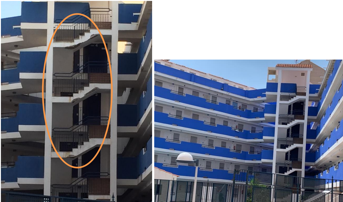
Imagen 28. Edificio con mantenimiento. Reparación de desconchamientos como consecuencia de la corrosión, imprimación de adherencia, relleno con mortero reparador y posterior pintado. Fuente: Propia.
