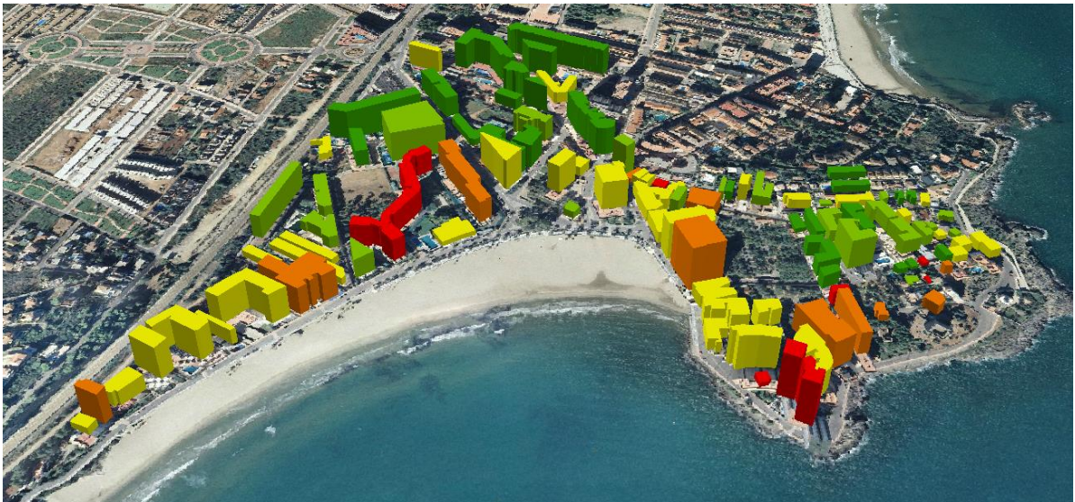
Imagen 30 a). Índices de vulnerabilidad en cada edificio. Fuente: ArcGis.
