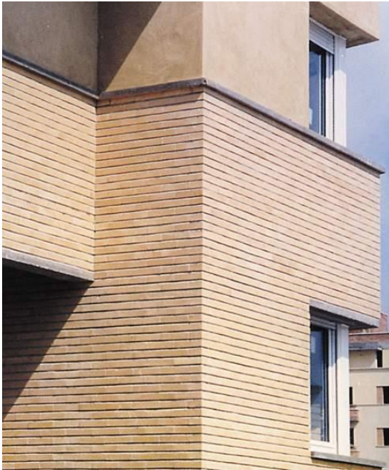
Imagen 7. Ejemplo de fachada con ladrillo caravista. Fuente: Propia
