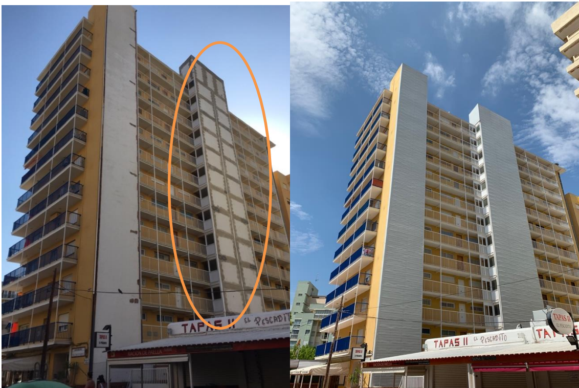
Imagen 27. Edificio con mantenimiento. Revestimiento metálico en fachada para proteger la estructura de la intemperie. Fuente: Propia.
