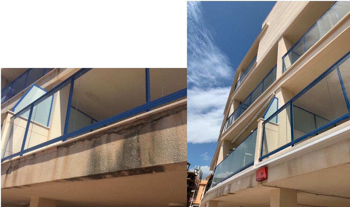
Imagen 25. Edificio con mantenimiento. Instalación de visera metálica y repintado para protección de frentes de forjado. Fuente: Propia.
