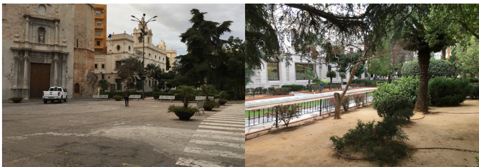
Figura 55. La plaza Mayor combina una zona de superficie dura y un espacio con vegetación Fuente: Elaboración propia
