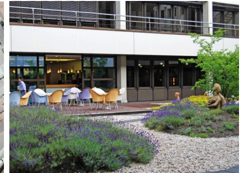
Edificio Deutschlandradio en Colonia, Alemania ( https://zinco-usa.com )
