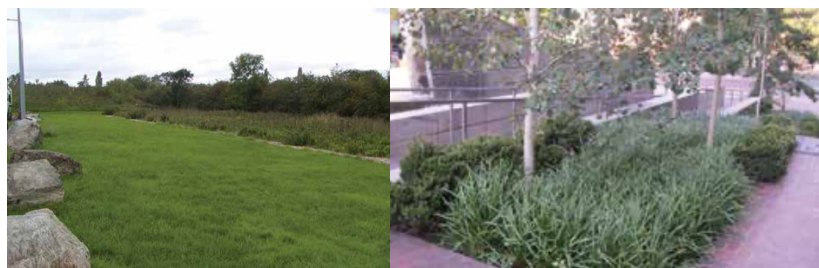
Figura 8. Franja de infiltración y alcorque de biorretención Fuente: The SuDS Manual (CIRIA, 2015)
