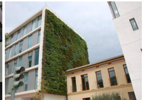
Instalaciones de la Estación de Telecomando y Estación Depuradora de Valencia ( http://www.v-ter.com )
