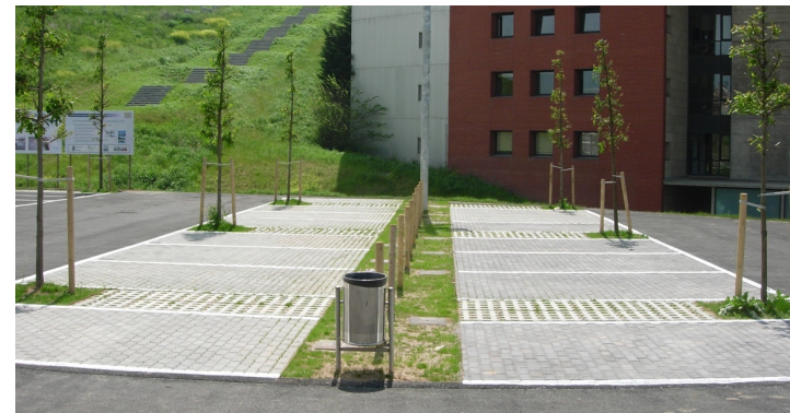
Aparcamiento con pavimento drenante y franjas de infiltración en Santander ( www.gitco.unican.es )
