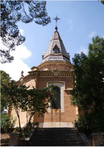
Figura 2. Vista general del panteón familiar del Marqués de Dos Aguas.
