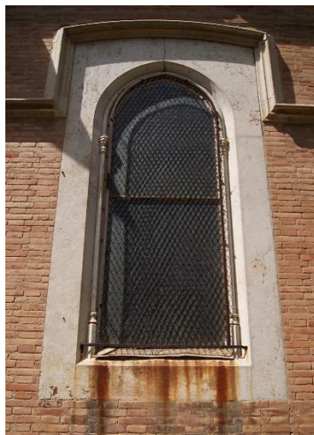
Figura 17. Enrejado de ventanal en arco.
