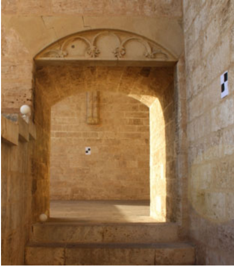
Ilustración 25: Imagen en las Torres de Serranos en las que aparecen 2 dianas y una esfera de las utilizadas en la toma de datos.
