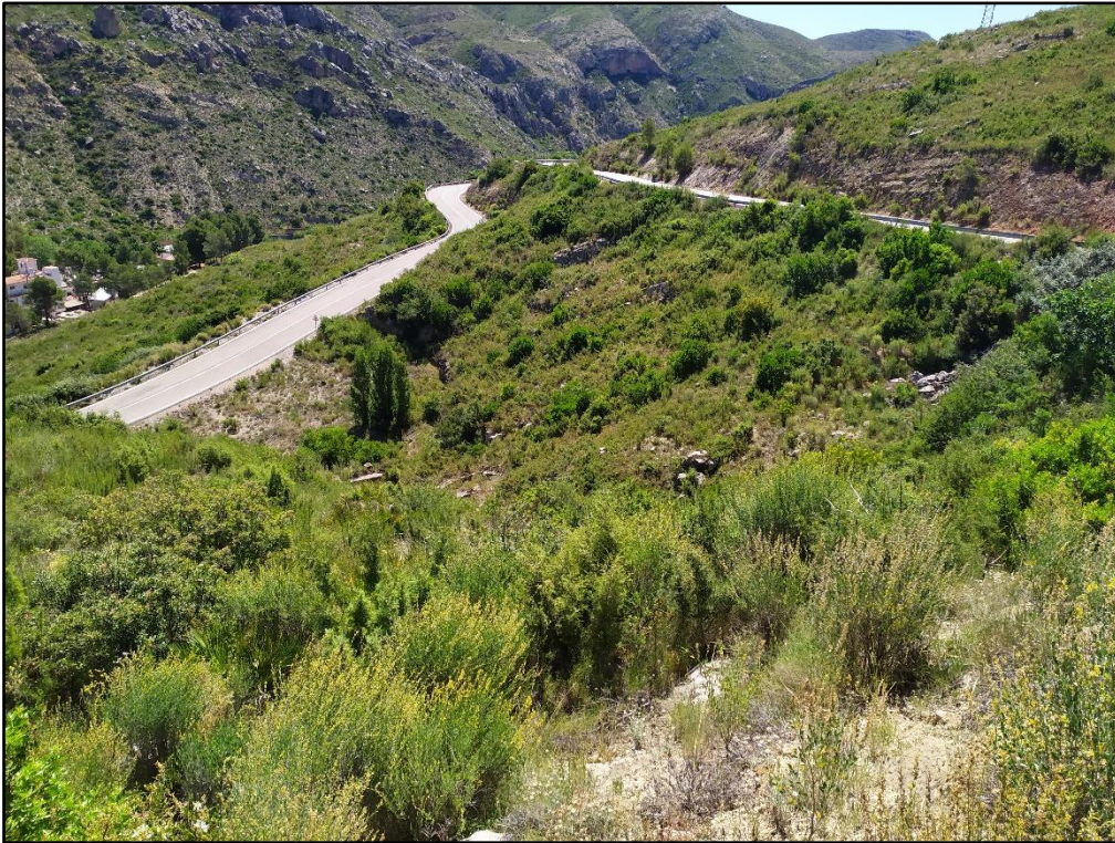
Figura 11. Fotografía 1 del Cantón 6. Fuente: Fotografía tomada el 04/06/2020.
