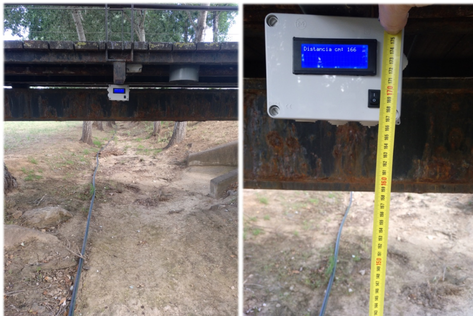
Figura 42. Mediciones del lecho del cauce del torrente
