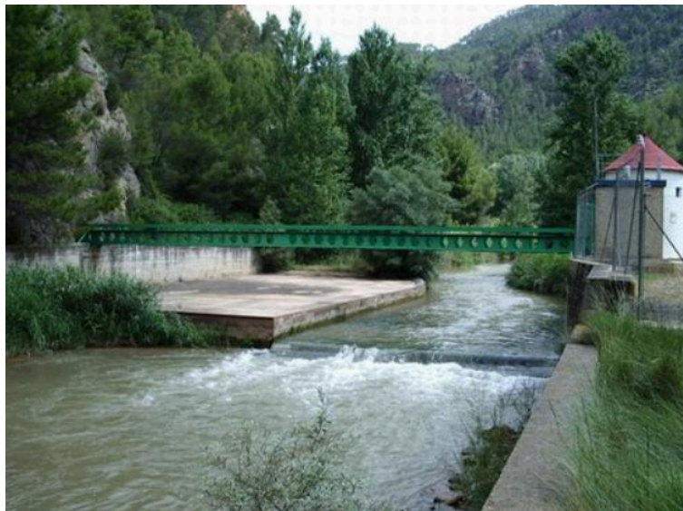
Figura 4. Estación de aforos, Zagra. Río Turia. Fuente CHJ (2020)
