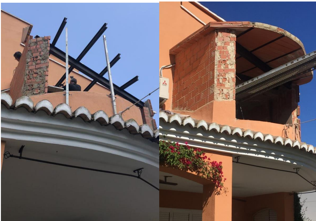
Fotografías 12 y 13. Ejecutando la cubierta
