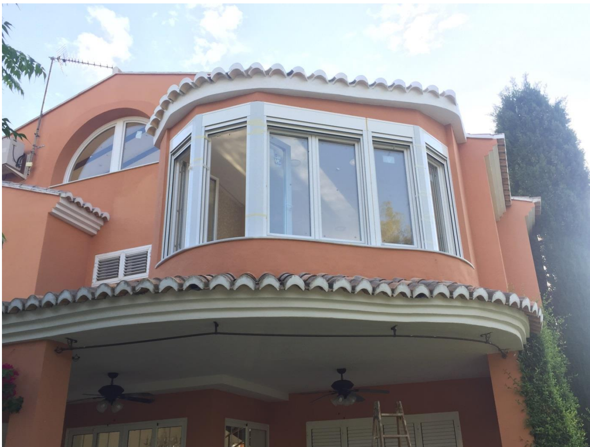
Fotografía 4. Estado final exterior.
