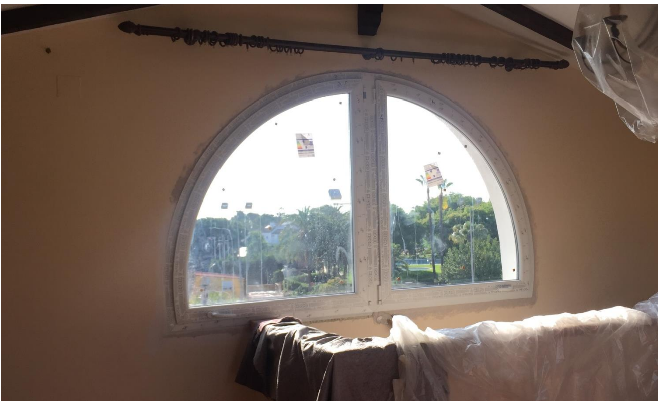
Fotografía 16. Ventanal semicircular con hojas abatibles en buhardilla.
