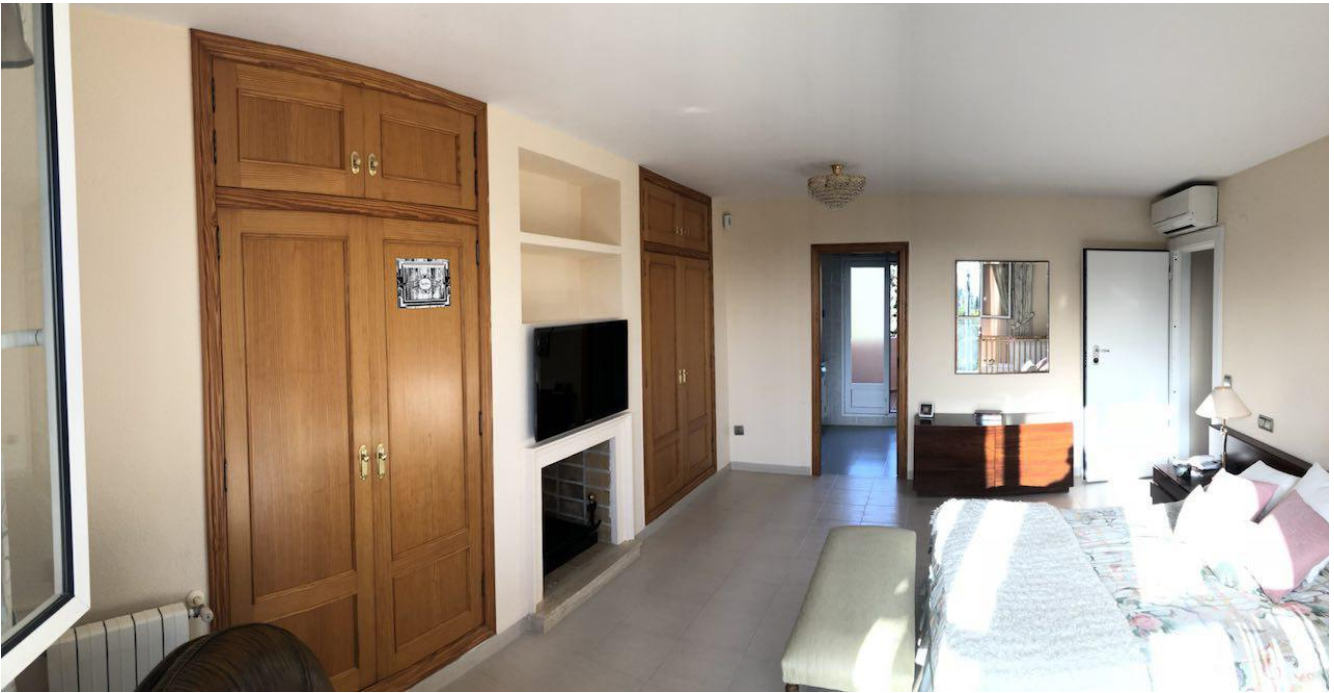
Fotografía 5. Estado inicial de la habitación principal.
