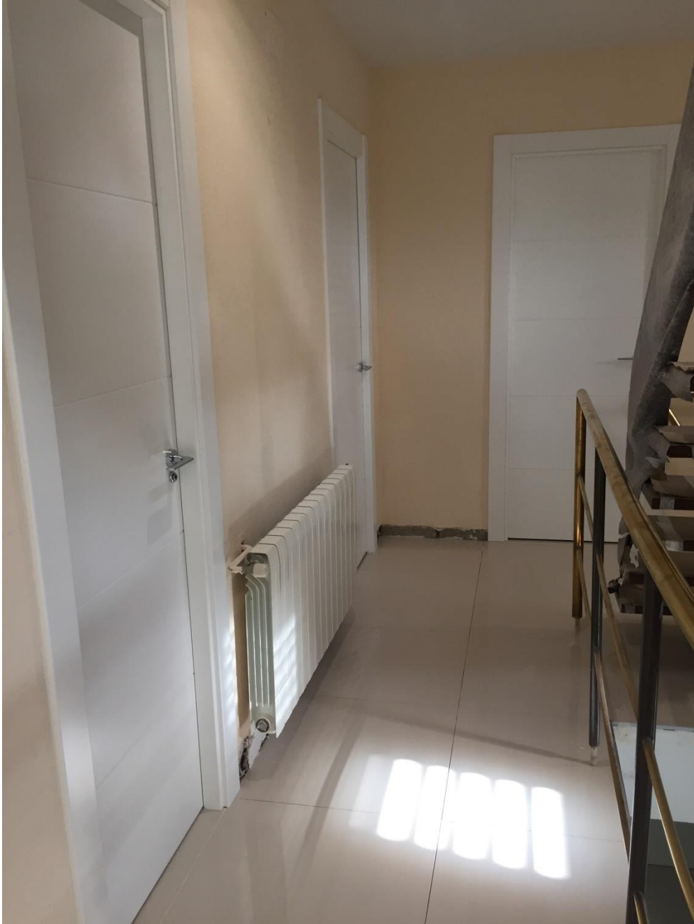
Fotografía 14. Puertas nuevas en primera planta.
