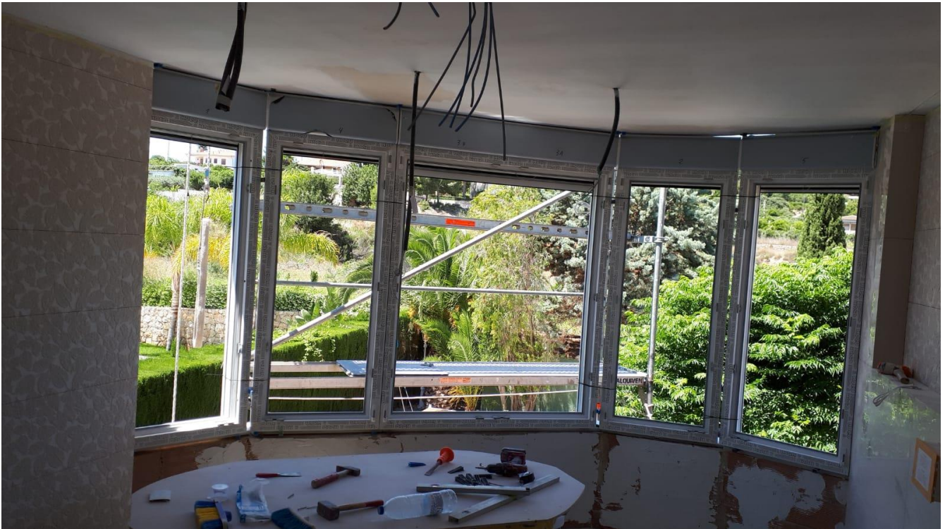
Fotografía 15. Mirador formado por cinco carpinterías oscilo batientes de PVC.
