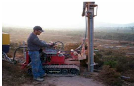
Estructura portante instalación FV y Máquina perforadora
