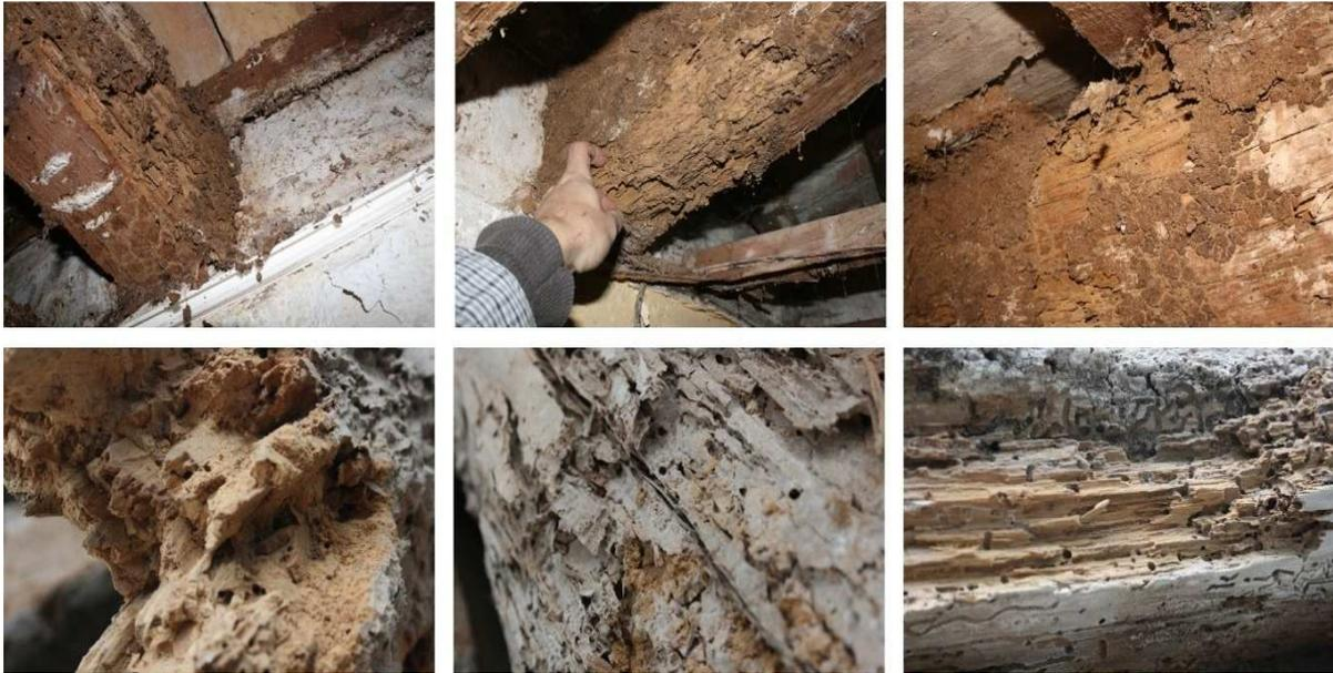
**Figura 4.** Acción de la termita en madera de uso estructural.
