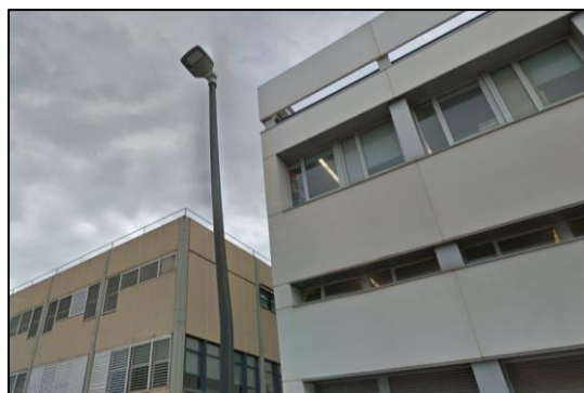
Figura 10 Edificios 3K (izq) y 3P (der).
