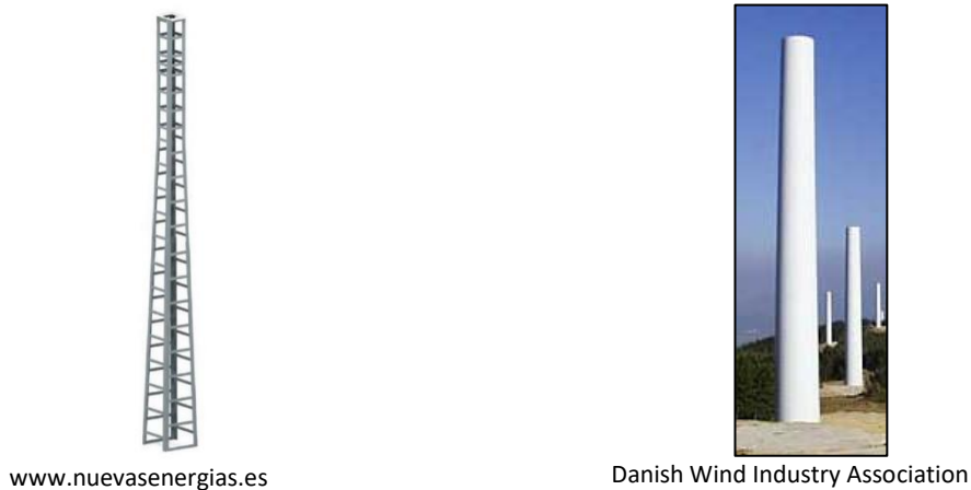
Figura 32 Torre de celosía (izq). Torre tubular (der)
