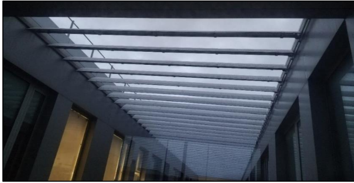
Figura 8 Tragaluz de la zona sur.
