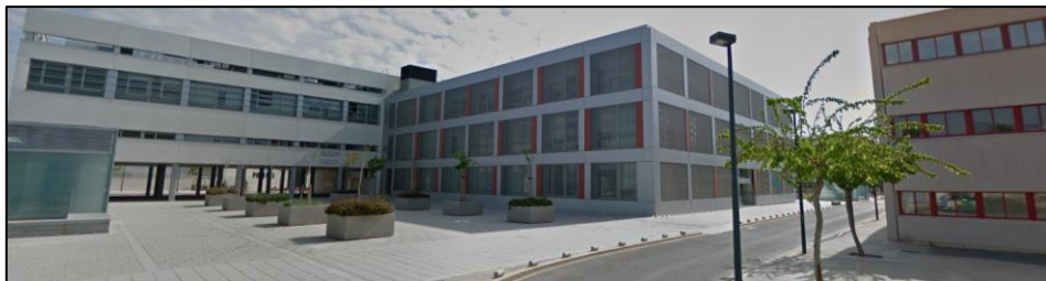
Figura 9 Edificio 3P vista desde el sur del edificio.
