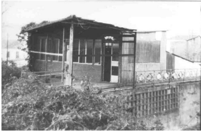
fig.85 Parte superior del edificio antes de las reformas previas a la apertura de la sala.
