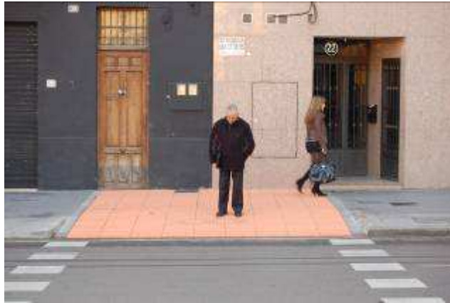
Figura 40. Paso de peatones con las baldosas hápticas de botones.
