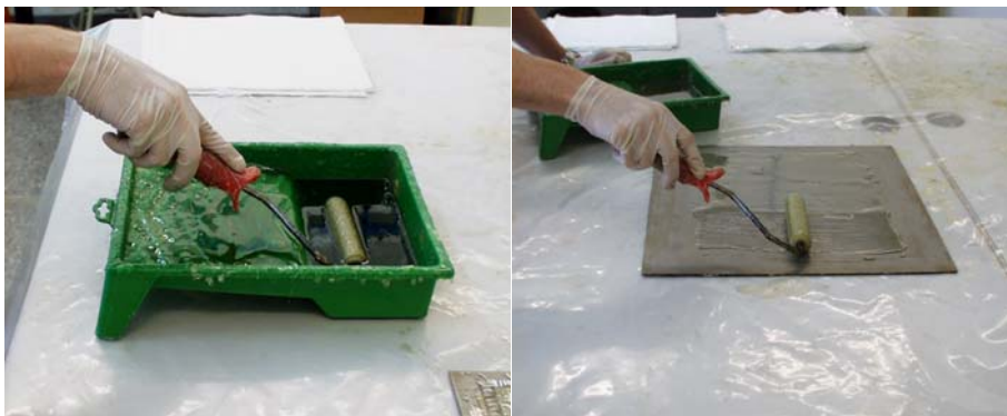
Figura IV.7. Aplicación de la primera capa de resina.
