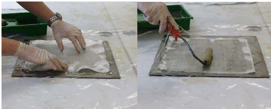
Figura IV.8. Primera capa de refuerzo.
