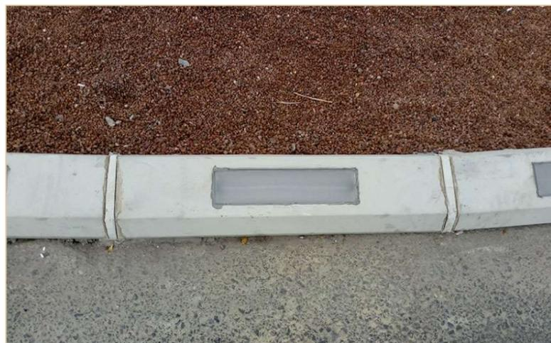
**Figura 82:** Detalle de bordillo luminoso para glorietas.
