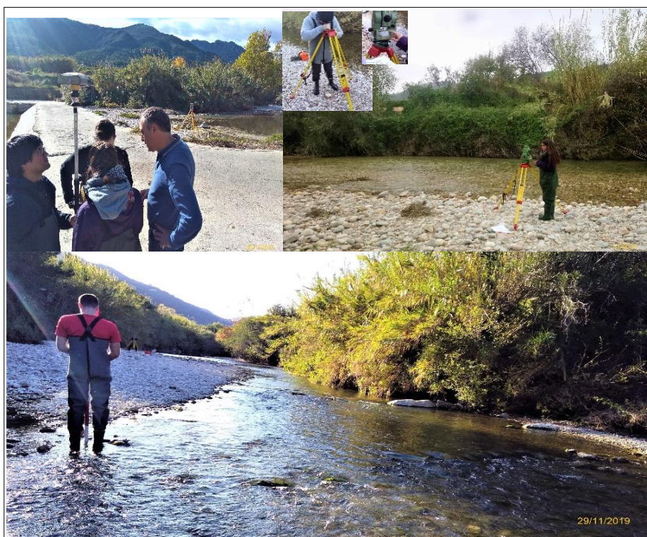
Figura N.º 11: Levantamiento topográfico con estación total. Fotografías de fecha noviembre 2019
