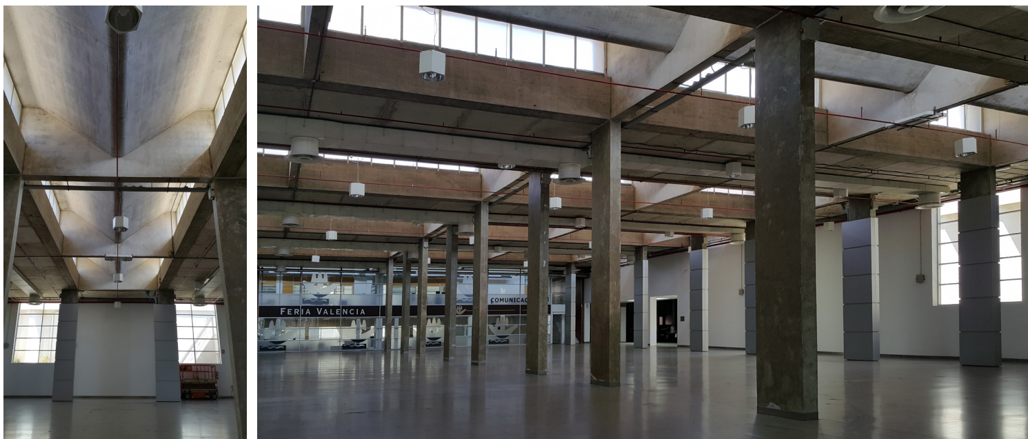
FIG. 15 Interior de la lonja existente. Fotografía de los autores (2015).
