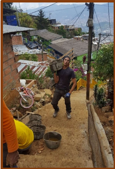
Foto: durante mi primera semana de observación participante: trabajando en la construcción colectiva de unas escaleras para el barrio Carpinelo II en la zona Nororiental.
