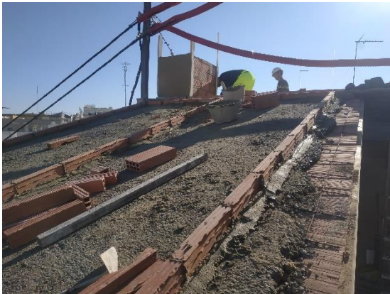
Ilustración 27. Ejecución de las diferentes capas que componen el faldón. Fuente: Propia
