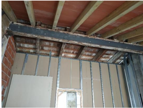
Ilustración 24: Ejecución de refuerzos en viga. Fuente: Propia
