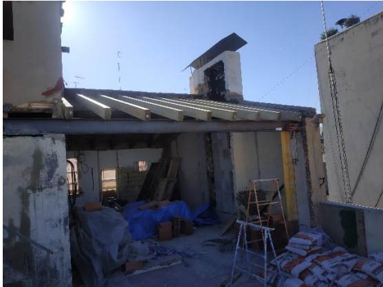
Ilustración 26. Colocación de las correas del nuevo faldón. Fuente: Propia
