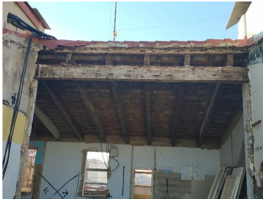
Ilustración 23: Demolición del faldón. Fuente: Propia
