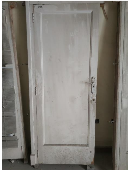
Ilustración 32. Carpintería interior a restaurar. Fuente: Propia
