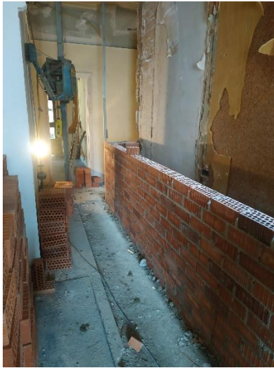
Ilustración 18: Ejecución de la ampliación de la caja de escalera. Fuente: Propia
