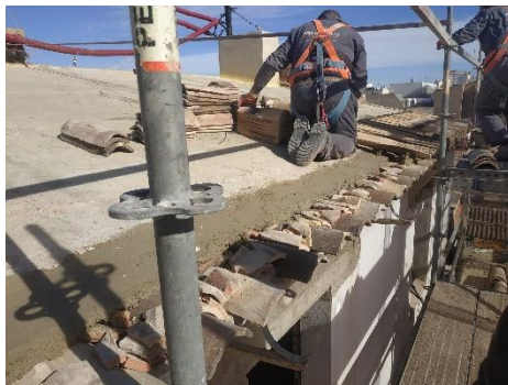
Ilustración 22: Trabajos de colocación de teja recuperada. Fuente: Propia
