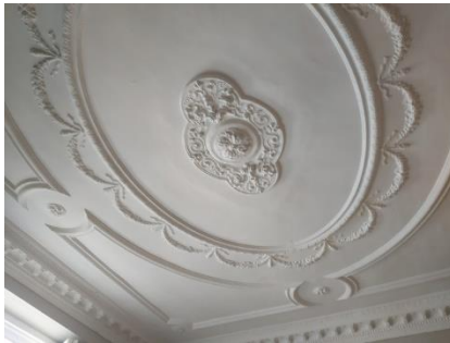
Ilustración 33: Falso techo a conservar. Fuente: Creación propia
