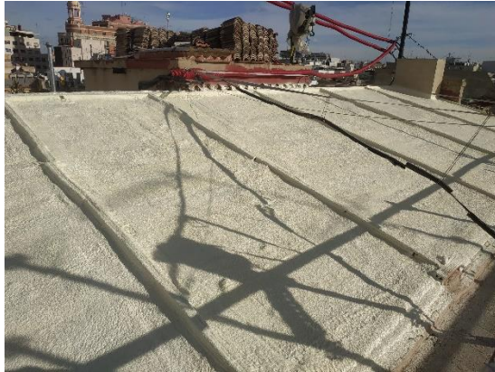
Ilustración 21: Ejecución de capa de aislamiento mediante poliuretano proyectado. Fuente: Creación propia
