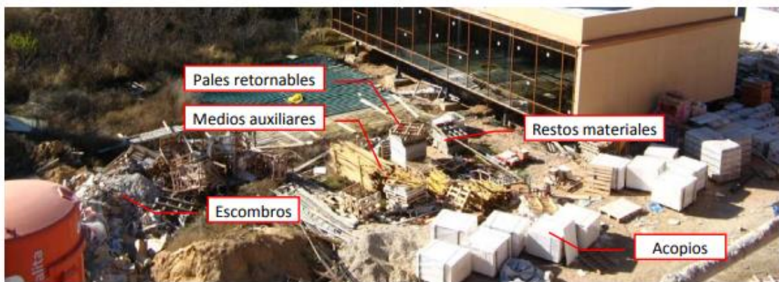
Ilustración 19, Identificación o clasificación de elementos en obra
