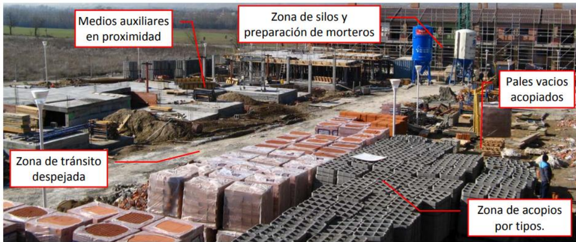
Ilustración 20, En la imagen podemos ver el orden de la zona de acopio de una obra. Fuente: Tesis “Aplicación de herramientas Lean en la Gestión de proyectos de edificación”, Gonzales 2013, pág.87
