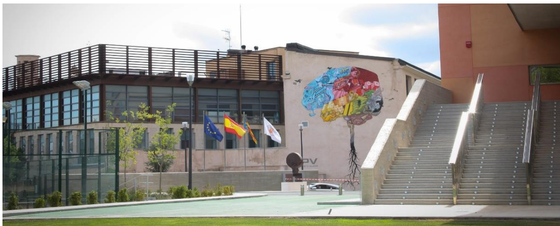
Ilustración 6: Exterior pabellón de la EPSA. Fuente: El periódico de Villena .
