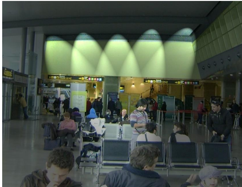
Ilustración 42 - Ejemplo de iluminación con focos
