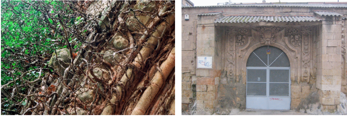
A la izquierda, el estado de abandono del Monasterio de Santa María la Imperial en Obarenes (Burgos). A la derecha, Ermita de la Misericordia, (Salamanca), a pesar de que su construcción remonta a 1389 actualmente carece de protección.
