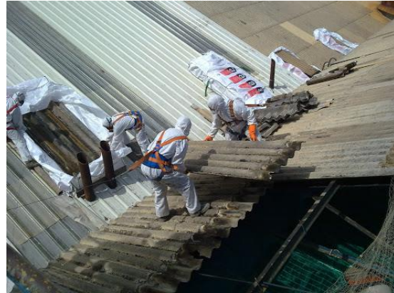
IMÁGEN 1: DESMANTELAMIENTO DE CUBIERTA DE FIBROCEMENTO
