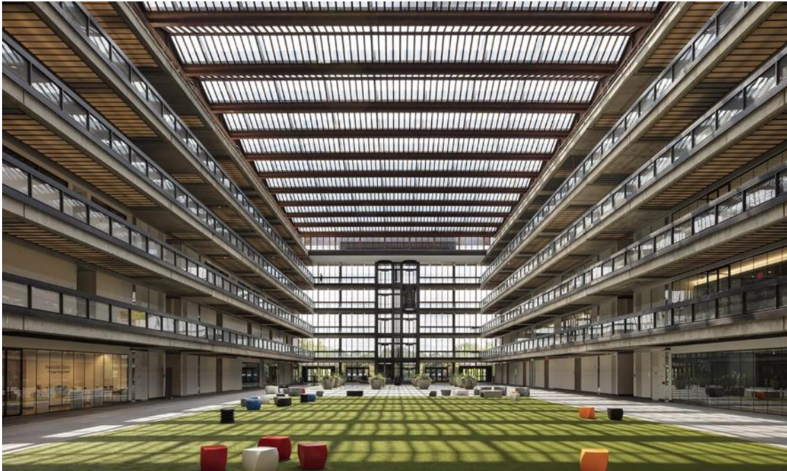
Fig 20 Lucernario fotovoltaico Bell Works in New Jersey. Fonte: OnyxSolar
