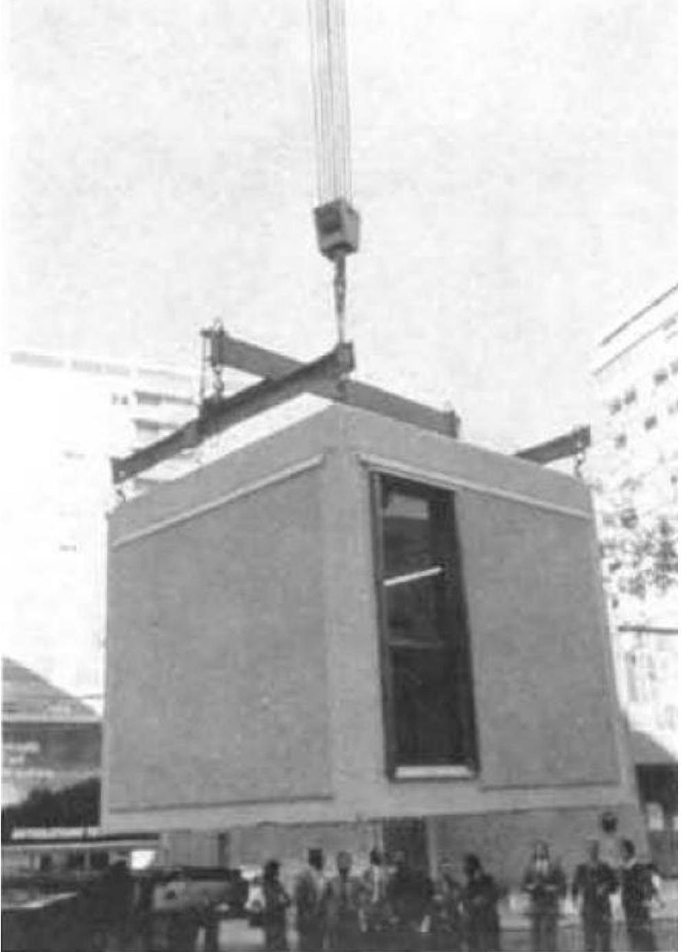
Figura 03.27 fotografía de la colocación del módulo *M43*. Fuente: G.O.D.B, «Construcción arquitectónica mediante módulos tridimensionales», IDLC, (1975): 57.
