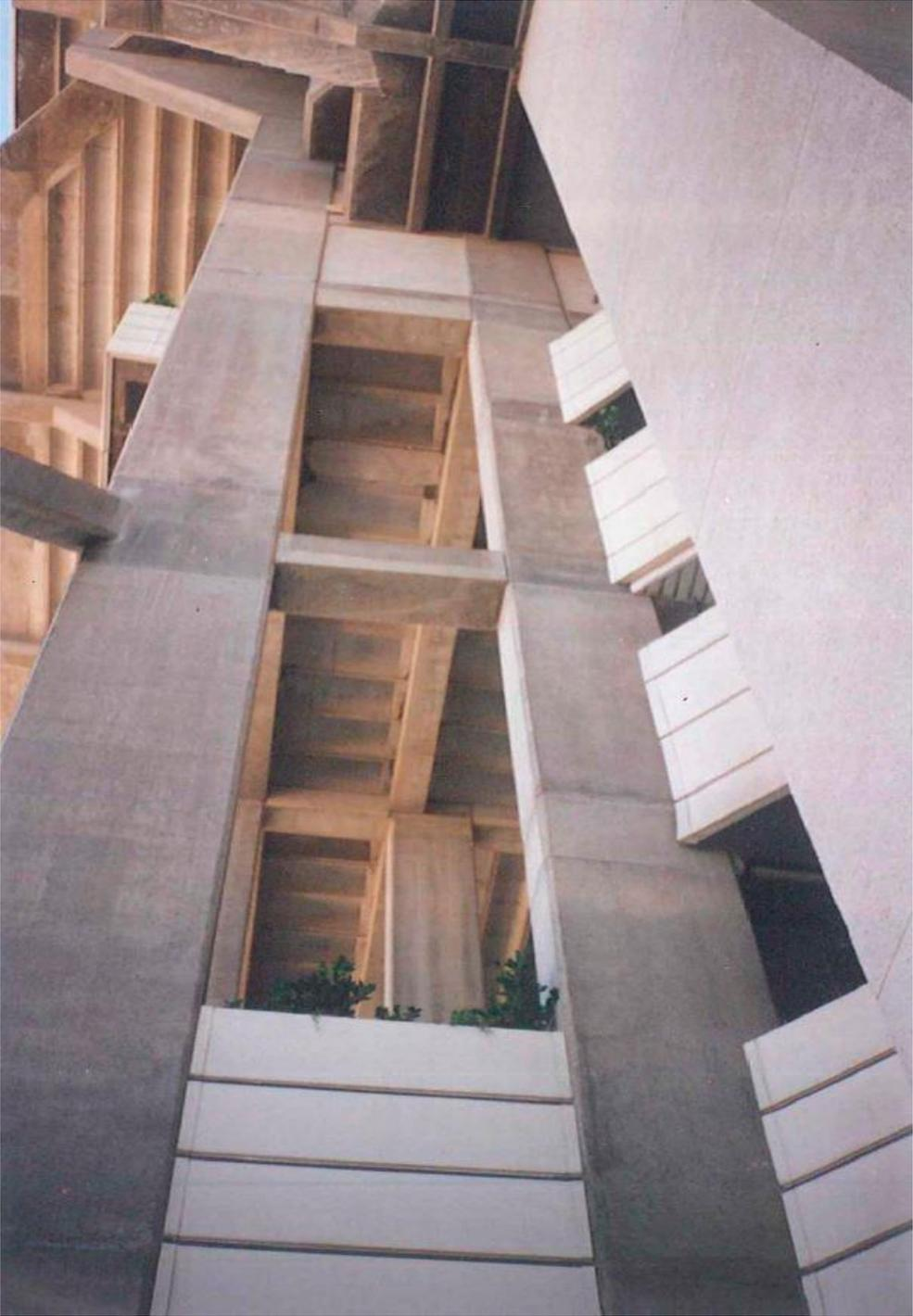
Figura 05.51. Fotografía de estructura sistema «silla». Año 1996. Fuente: Archivo personal de Cortés.
