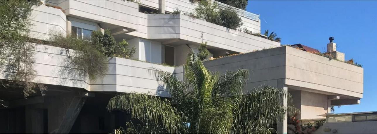
Figura 07.6 Fotografía cambio de materialidad en jardineras, fase 1ª poliéster con fibra de vidrio (iza) y 3ª enfoscado de mortero blanco con piedra de mármol (dcha.). Año 2019. Fuente: Fotografía del autor.
