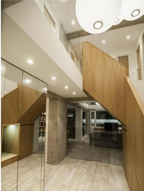
Figura 06.22 Fotografía de la reforma de una de las viviendas en *Espai Verd*, en el que se ha sustituido la escalera de caracol por una nueva de geometría en L Fuente: «Vitale: Dúplex Valencia», acceso el 14 de noviembre de 2019, <https://www.vitale.es/en/project/es-reforma-duplex/>
