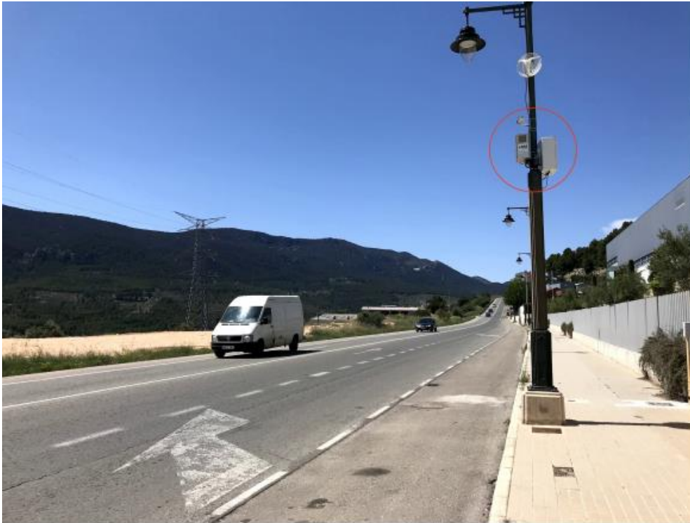
Ilustración 16: Cámara de acceso a Batoi. Fuente: (Pascual, 2019).
