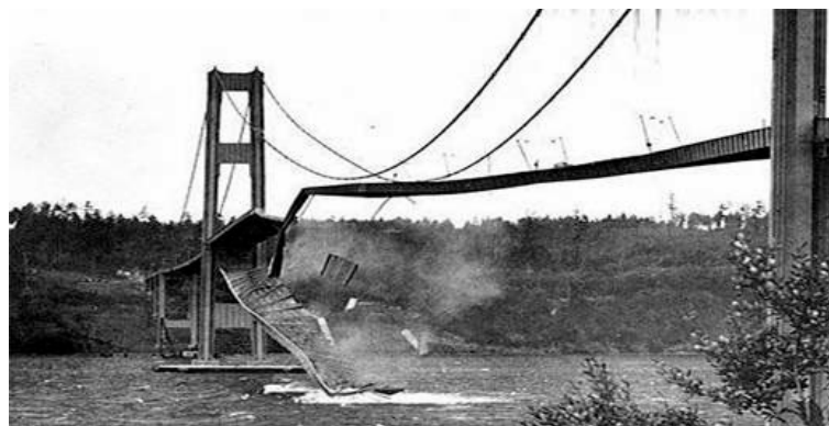
Figura III.40. Colapso del puente de Tacoma producido por el fenómeno de resonancia 53 .
