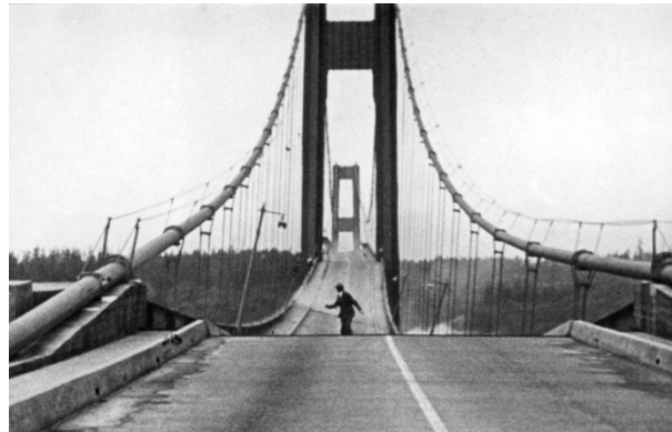
Figura III.39. Oscilación del puente de Tacoma producido por el fenómeno de resonancia 52 .
