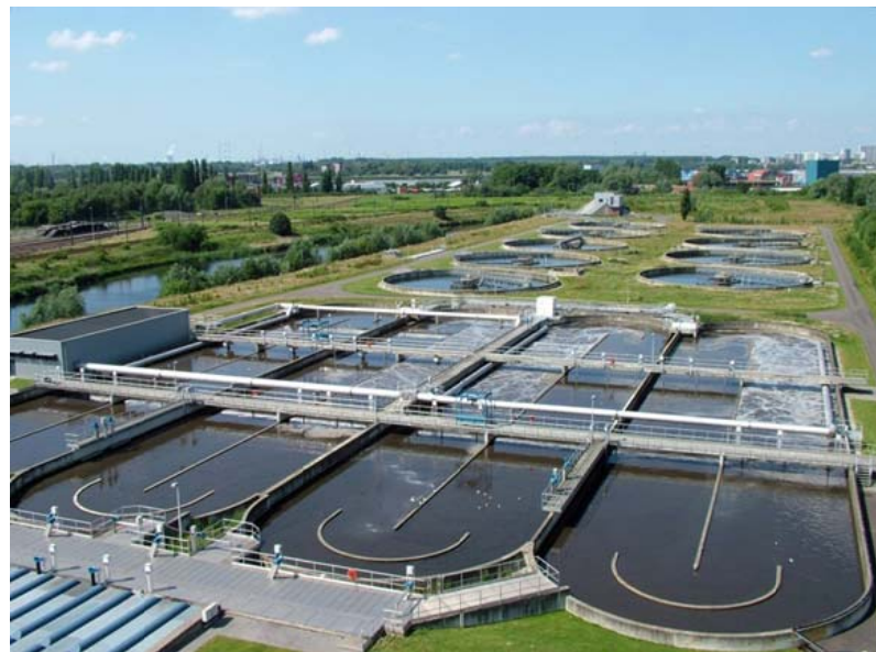
Ilustración 3: Vista aérea del funcionamiento de una EDAR
