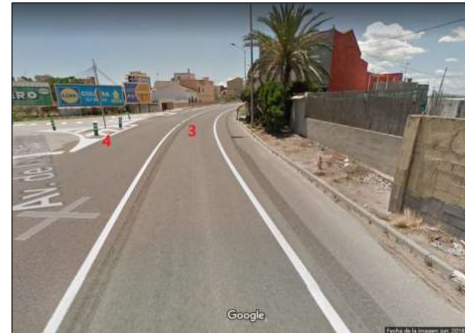
Figura 51: Vista sentido del perello aproximándose a la intersección
