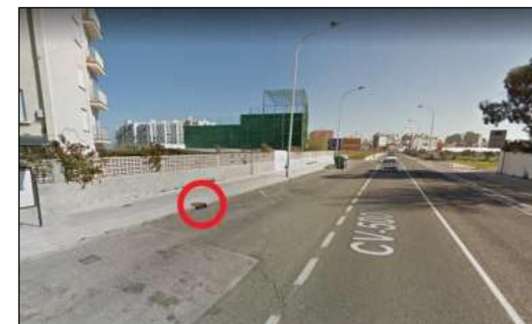
Figura 76: Obra de drenaje, sumidero en la CV-500 (Google Maps)
