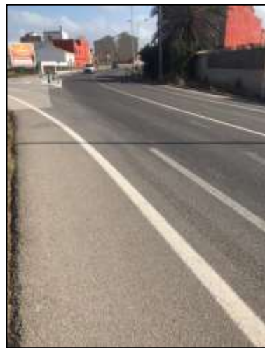
Figura 39: Buen estado del firme (foto tomada el 11/07/2020)
