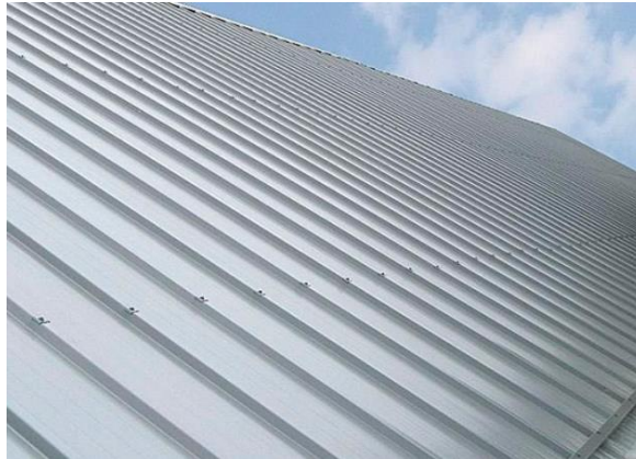
Ilustración 27 Cubierta chapa de acero galvanizado
