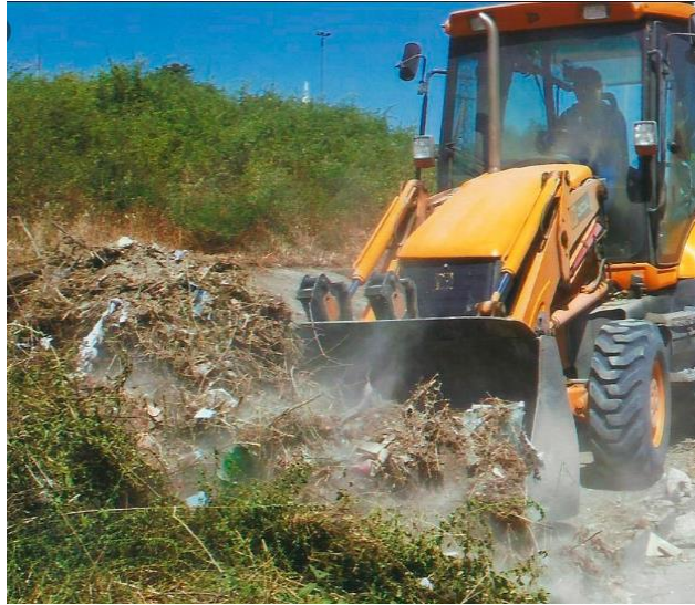
Ilustración 21 Desbroce y limpieza del terreno con maquinaria
