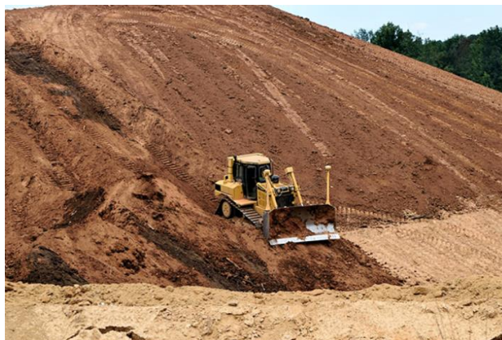
Ilustración 22 Excavación y movimiento de tierras
