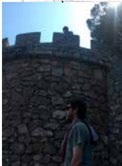
TORRE DE AGUA
