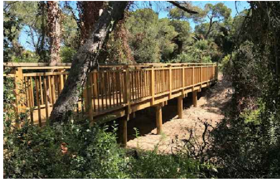
Detalle del puente
