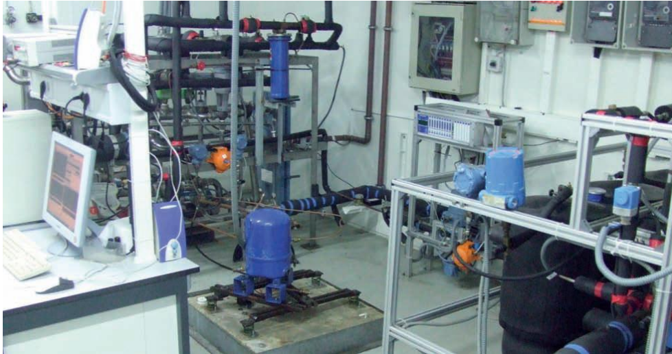
Figura 2.1. Compresor MTZ32/4 instalado en el banco de ensayos.
