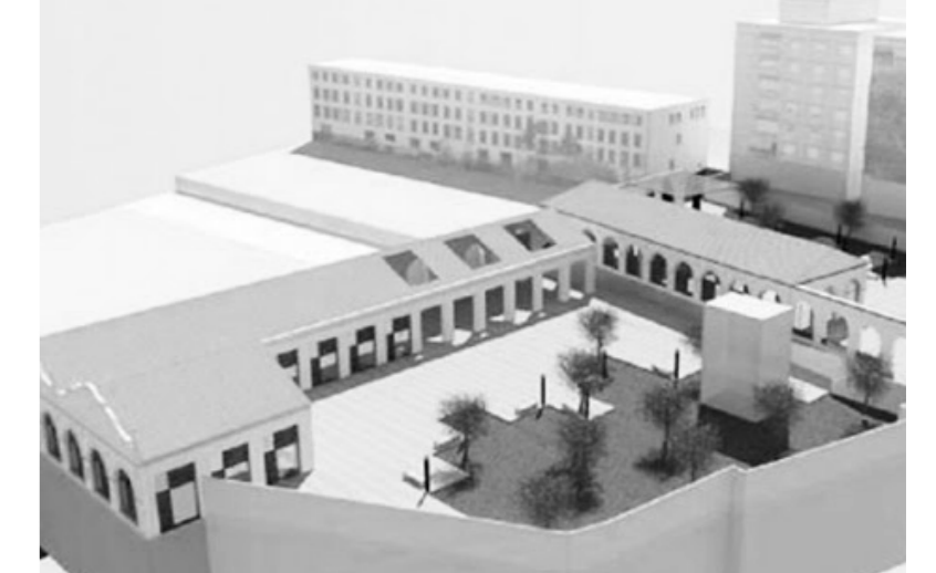
Obras del futuro museo e imagen del proyecto de reforma.
