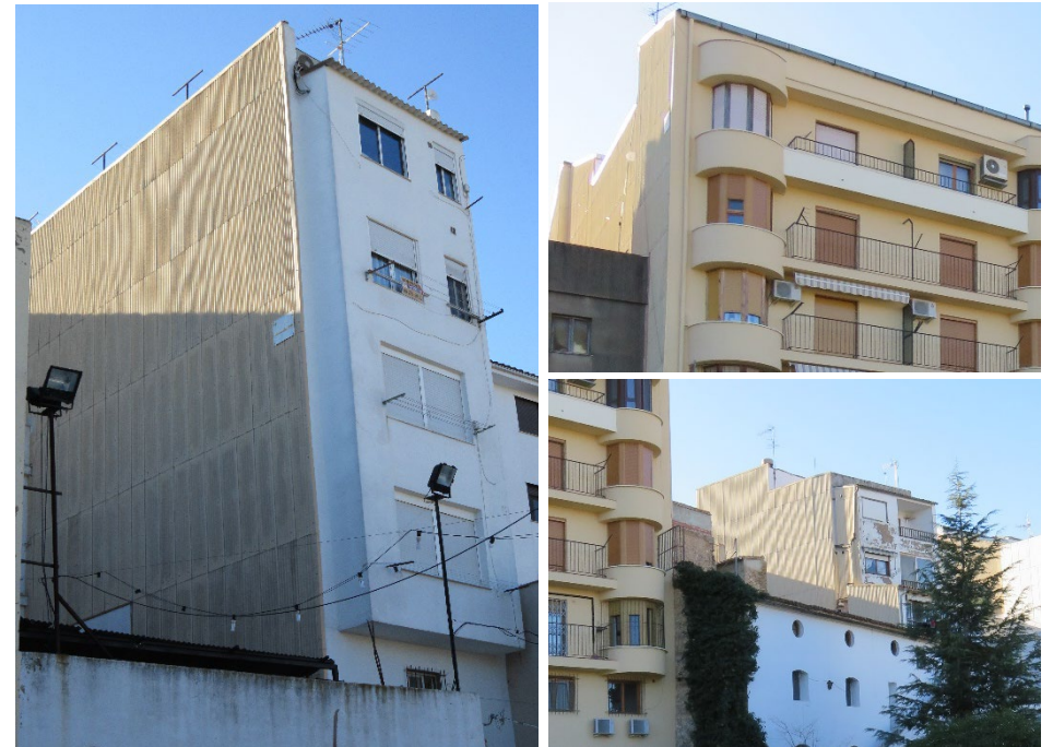
Edificaciones adyacentes al solar: vemos el uso de paneles de fibrocemento con acabado de minionda como protección térmica en las medianeras. Supone el punto de partida en la ideación material del proyecto.
