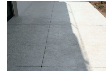
02 | PLACAS DE HORMIGONADO IN SITU EN TONO GRIS CLARO
