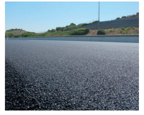
04 | CAPA DE RODADURA / ASFALTO
