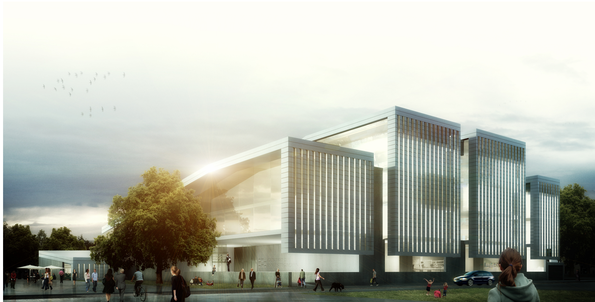
Fachada Este. Vista Parque Calle Alfons Verdeguer.
