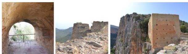
Figura. 5. Espacio acasamatado en la cortina a flanqueante central. En el centro flanco con cañonera en el sector meridional del castillo. A la derecha muros de tapia de la estructura de la celosía (G y N, 2016).
