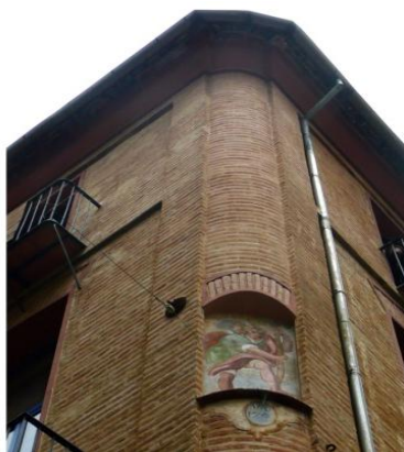
FIG. 91 Corte de ladrillos en un taller artesanal gracias a la guía de una caja de madera con plantillas (CAMBELL-PRICE). Soluciones con ladrillos aplantillado y escafilado para aleros y esquinas, vivienda de la C/ Carniceros (Va104) en Valencia (CRISTINI)
