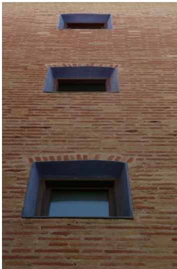
FIG. 83 Muro con doble sellado de tendeles, de asiento y de acabado; vivienda en la C/ San Ramón (Cd15), Valencia (CRISTINI)
