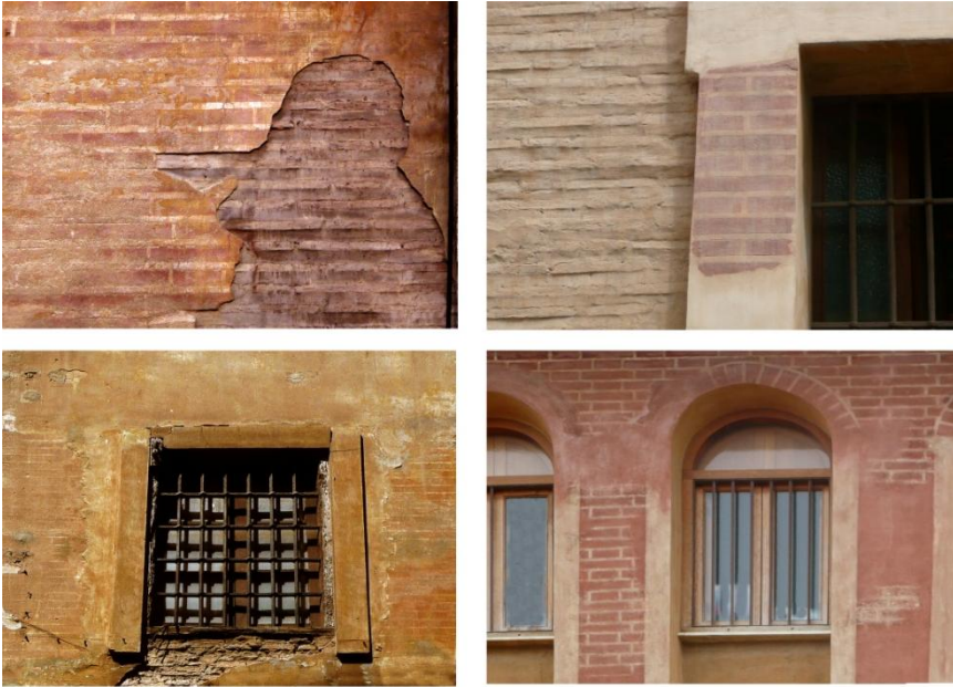
FIG. 101 Acabados con ladrillos fingidos en edificios de la I P.za de la Cruz (Ce101), C/Gutenberg (Cf42) en Valencia (CRISTINI)
