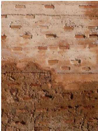
FIG. 133 Detalle de reconstrucción de fábricas de tapia valenciana, Mascarell, Castellón (CRISTINI)
