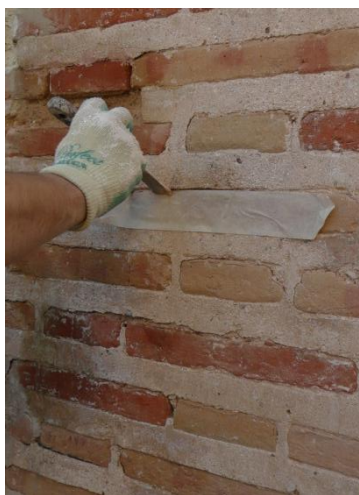
FIG. 124 Protección y consolidación, viviendas de C/Roger de Flor nº39, Valencia (CRISTINI)
