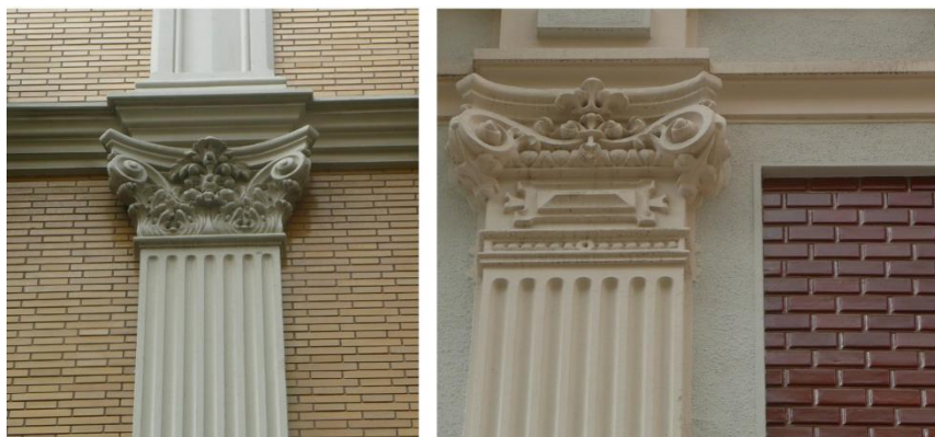
FIG. 89 Fachadas con ladrillos vidriado; viviendas en C/ de la Pau, Valencia (CRISTINI)
