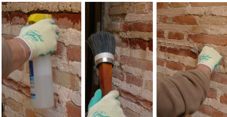
FIG. 130 Reparación de fisuras y perfiles de juntas históricas, viviendas de C/Roger de Flor nº39, Valencia (CRISTINI)
