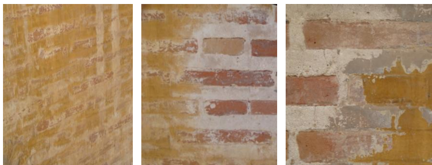
FIG. 119 Detalle de limpieza, varias intensidad de proyección con cáscaras de almendras, viviendas de C/Roger de Flor nº39, Valencia (CRISTINI)
