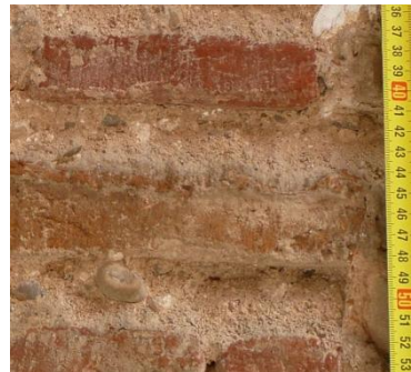
FIG. 112 Detalles de disgregación de las juntas, fichas Cg02 y Xc94 (CRISTINI)
