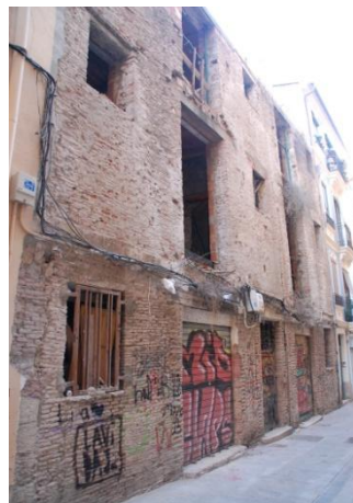
FIG. 143 Efecto "scraping", muy común en edificios de viviendas sin alto grado de protección. Edificio en la C/Avellanas nº5, ficha Xe 14 y viviendas C/Belén nº7, ficha Ma48 (CRISTINI)
