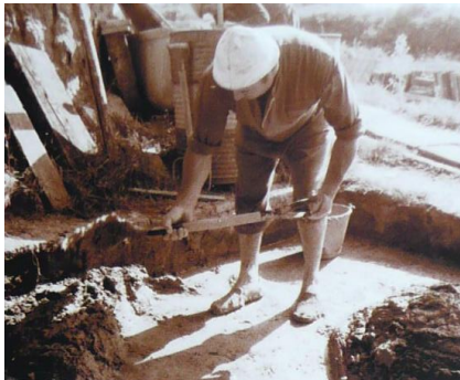
FIG. 46 Terraires y bassers moldeando ladrillos, en un rajolar de Granollers (CORNELLAS)
