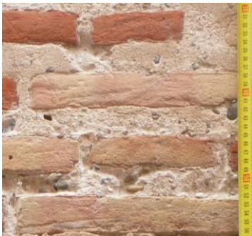
FIG. 112 Detalles de disgregación de las juntas, fichas Cg02 y Xc94 (CRISTINI)
