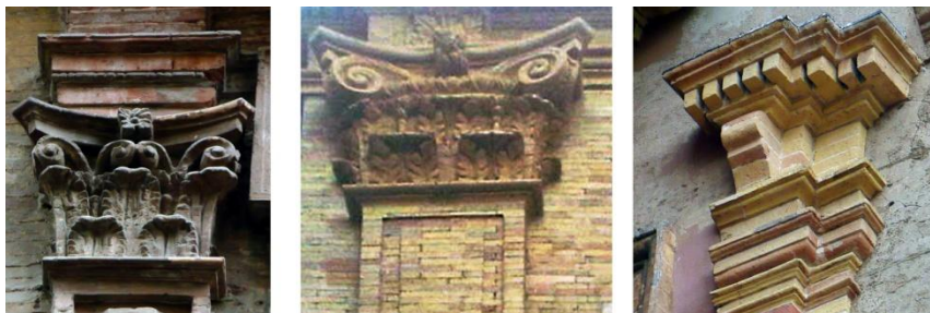
FIG. 94 Detalles de ladrillos escafilados en la Capilla de la Iglesia de S. Martín (Fa105) y en la fachada trasera de la Iglesia de la Virgen de los Desamparados (Xd65) (CRISTINI)
