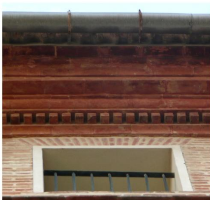
FIG. 90 Soluciones con ladrillos aplantillados para aleros y esquinas, Palacio Pineda (Ce71) en Valencia (CRISTINI)
