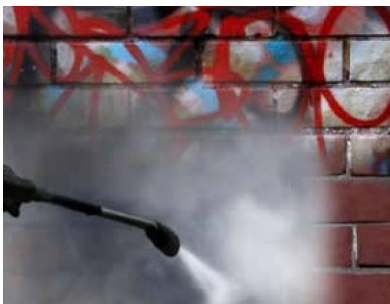
FIG. 113 Ejemplos de diferentes tipos de limpieza a base de agua, con distintos métodos de proyección (CRISTINI)
