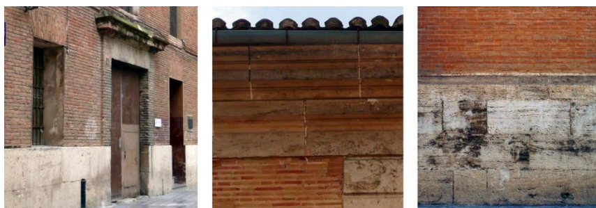
FIG. 85 Muros con ladrillos visto yuxtapuesto con piedra (en zócalos o columnas adosadas...); conjunto del Seminario (Xc16), complejo de la Nau (Fa39), sacristía de la Iglesia de la Congregación (Xf26) (CRISTINI)
