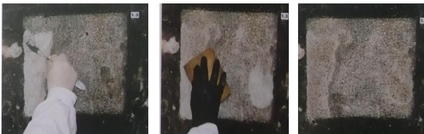
FIG. 123 Limpieza con compuestos de celulosa en fábricas previamente limpiadas (FEIFFER)
