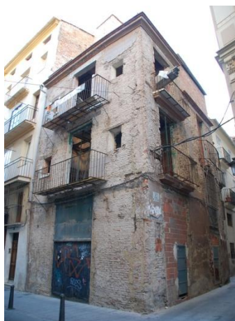
FIG. 143 Efecto "scraping", muy común en edificios de viviendas sin alto grado de protección. Edificio en la C/Avellanas nº5, ficha Xe 14 y viviendas C/Belén nº7, ficha Ma48 (CRISTINI)
