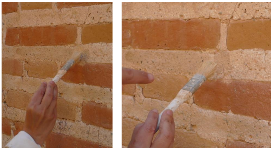
FIG. 131 Consolidación con agua de cal de micro fisuras, viviendas de C/Roger de Flor nº39, Valencia (CRISTINI)
