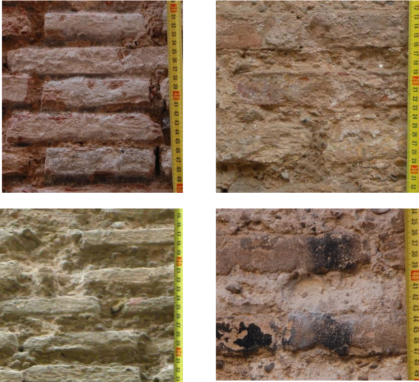
FIG. 113 Detalles de pulverización de las juntas, fichas Ma84, Xc78;; abajo Ca15, Ma92(CRISTINI)
