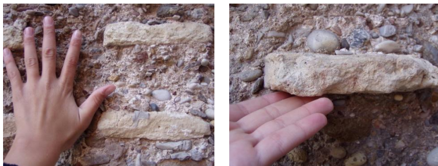
FIG. 77 Tapia valenciana. Detalles de refuerzo con ladrillos en la muralla cristiana de la ciudad de Valencia (Cb65) (CRISTINI)
