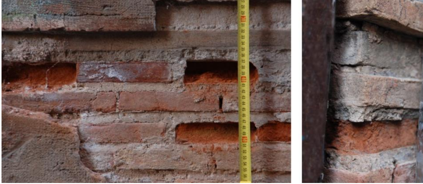
FIG. 87 Almohadillado en un alzado; viviendas en la C/Cadirers (Ma82) en Valencia (CRISTINI)
