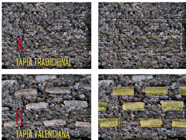
FIG. 81 Diferencias entre tongadas de tapia de argamasa y tapia valenciana (CRISTINI)
