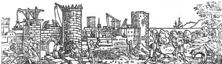
FIG. 30 Valencia, fases de construcción de la muralla cristiana, donde se aprecian los encofrados de tapia; por BREUER, portada de "Primera Parte de la Crónica General de toda España y especialmente del Reino de Valencia" 1546 (SERRA DESFILIS)
