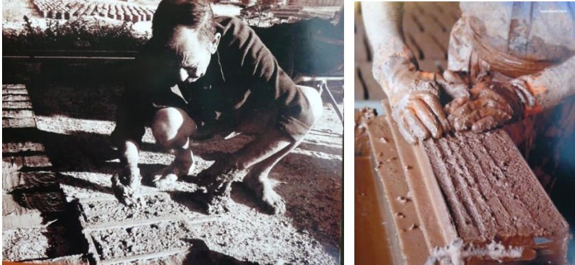
FIG. 47 Rajoleres y bailos moldeando ladrillos, en un rajolar de Granollers (CORNELLAS)
