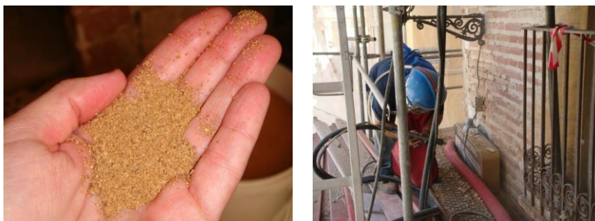
FIG. 118 Detalle de limpieza con método mecánico, proyección abrasiva en seco con cascaras de almendras en las viviendas de C/Roger de Flor nº39, Valencia (VEGAS-MILETO)
