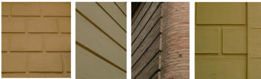
FIG. 88 Posibles soluciones de "ladrillos para almohadillados" en viviendas del Barrio de San Francesc y de la Seu-Xerea, Valencia (CRISTINI)
