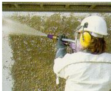
FIG. 113 Ejemplos de diferentes tipos de limpieza a base de agua, con distintos métodos de proyección (CRISTINI)
