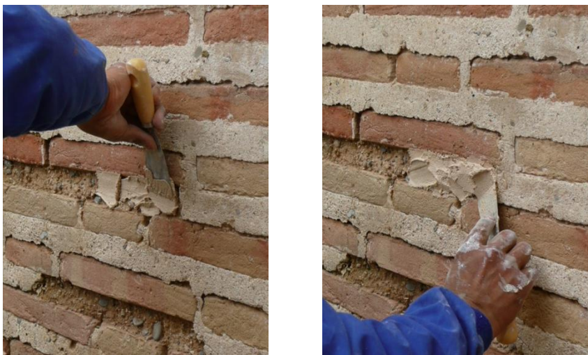
FIG. 128 Reparación de juntas, viviendas de C/Roger de Flor nº39, Valencia (CRISTINI)
