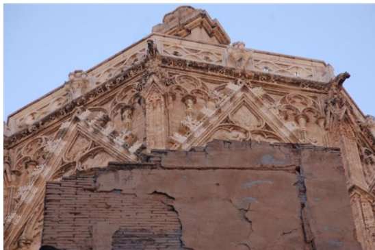
FIG. 97 Fábrica de ladrillo enlucido, C/Subida del Toledano, Valencia (CRISTINI)
