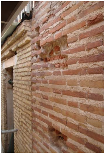
FIG. 127 Sustitución de piezas en viviendas de C/Roger de Flor nº39, Valencia (VEGAS-MILETO)
