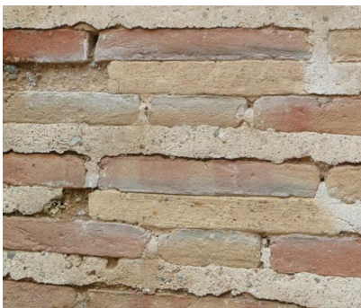
FIG. 129 Pruebas de entonado de morteros, viviendas C/Roger de Flor nº39, Valencia (CRISTINI)
