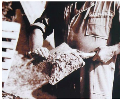
FIG. 46 Terraires y bassers moldeando ladrillos, en un rajolar de Granollers (CORNELLAS)
