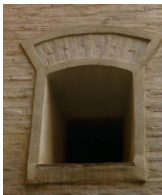
FIG. 160 Solución frecuente a lo largo de S. XVIII con arco de extradós e intradós curvo (tipo V6) en un detalle de la ficha Cg57 (CRISTINI)
