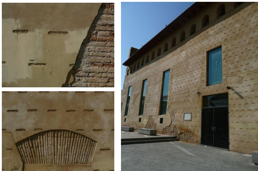
FIG. 138 Simulación de tapia valenciana, Gremio de Carpinteros, Valencia, ficha Va34 (CRISTINI)
