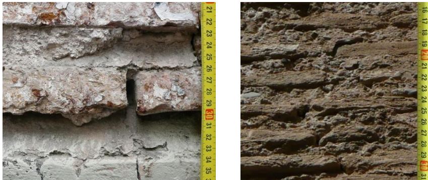
FIG. 108 Detalles de disgregación en ladrillos, fichas Ca55 y Cf23 (CRISTINI)
