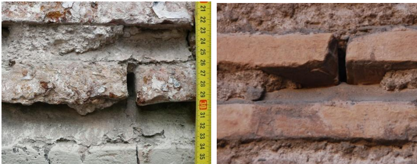
FIG. 142 Secuencia de juntas estructurales y de acabado, Capilla de la Iglesia de S. Juanes, ficha Me212a y Vivienda C/Quart nº16, ficha Cb55 (CRISTINI)
