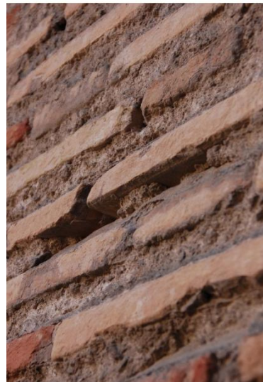
FIG. 83 Muro con doble sellado de tendeles, de asiento y de acabado; vivienda en la C/ San Ramón (Cd15), Valencia (CRISTINI)
