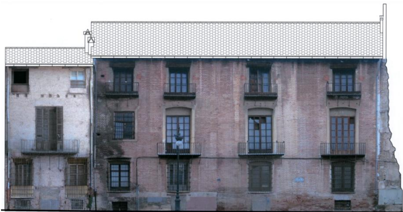
FIG. 99 Palacio de la Calle Eixarcs (Va81/82), alzado con acabado de ladrillos fingidos (CRISTINI)
