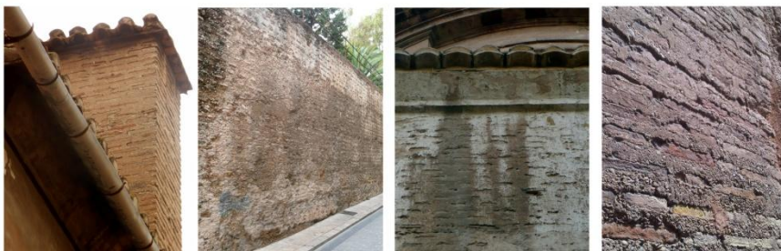
FIG. 78 Tapia valenciana en algunos edificios religiosos/monumentales intramuros; (a la izquierda) alzado de la Iglesia de San José (Cg14), muralla junto a las Torres de Quart (Cb65), cerca del Monasterio del Carmen (Cgo1b), alzado del Convento del Pilar (Vb67) (CRISTINI)
