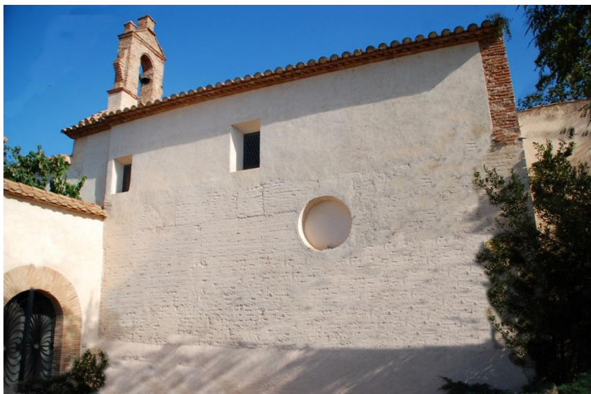
FIG. 141 Ejemplo de tratamiento de superficie; encalado en una fábrica de tapia valenciana, S. Jaume de Fadrell, Castellón. (CRISTINI)
