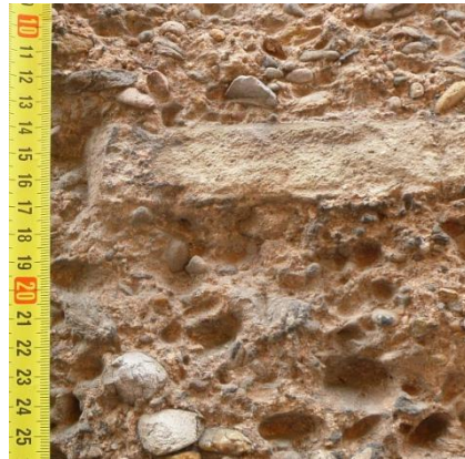
FIG. 134 Tapial, encofrado en el que se apisonan argamasa de tierra, cal y grava en estratos regulares (ADAM-CRISTINI)
