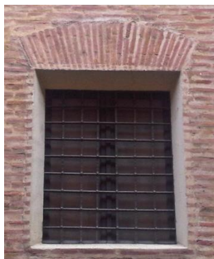
FIG. 159 Solución frecuente desde finales de S. XVI hasta mitad del S. XVIII con arco de extradós curvo, intradós plano (tipo V7). Las soluciones primigenias son más peraltadas, las tardías más abombadas; en la imagen un detalle de la ficha Xe66. (CRISTINI)
