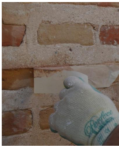
FIG. 124 Protección y consolidación, viviendas de C/Roger de Flor nº39, Valencia (CRISTINI)
