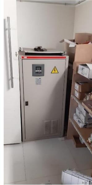
*Ilustración 45. Batería de condensadores*
