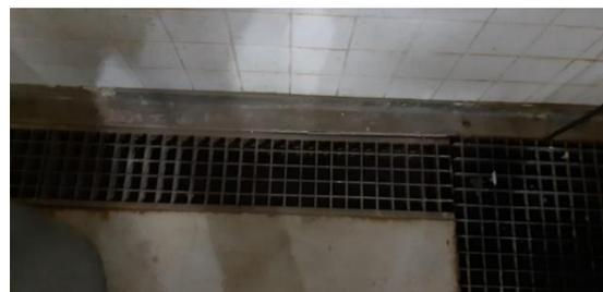
*Ilustración 20. Canales drenaje trámex 2*
