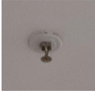
*Ilustración 65. Rociador tubería mojada*
